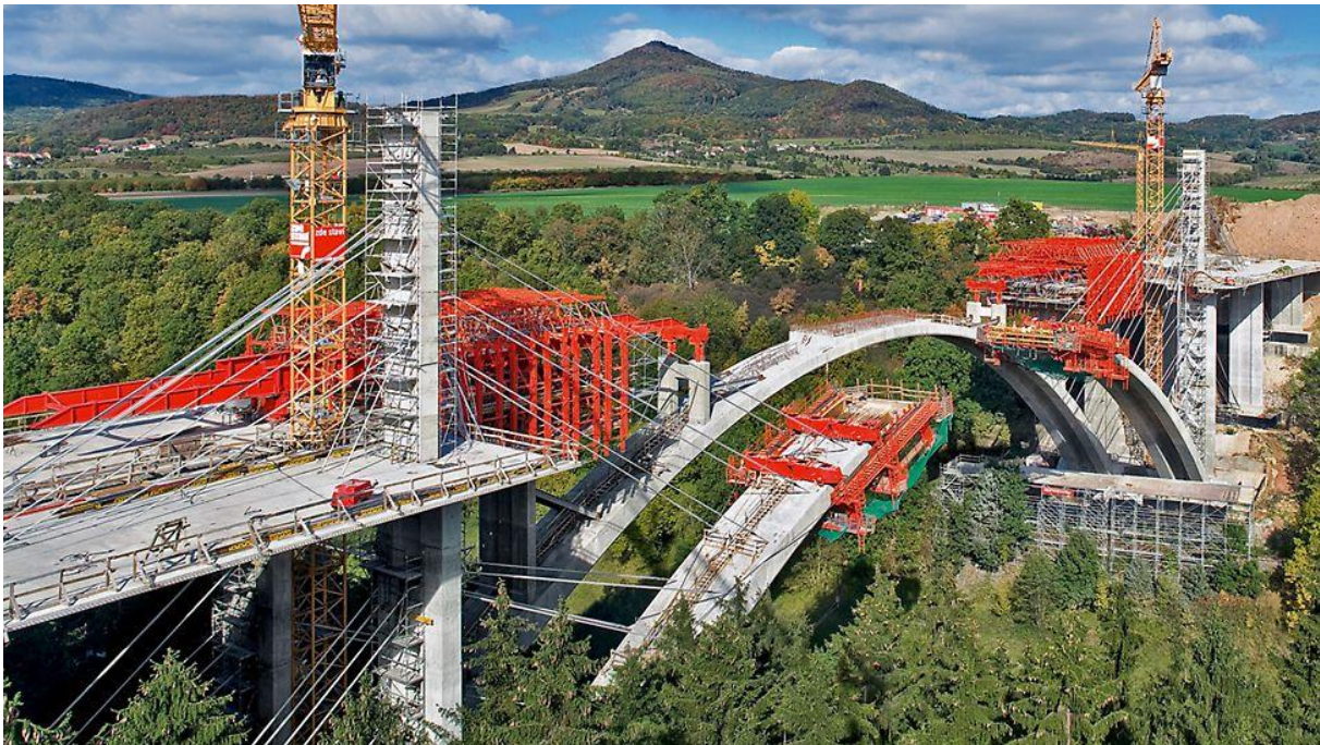
Obrázek 49: Stavba mostu Oparno [21]
