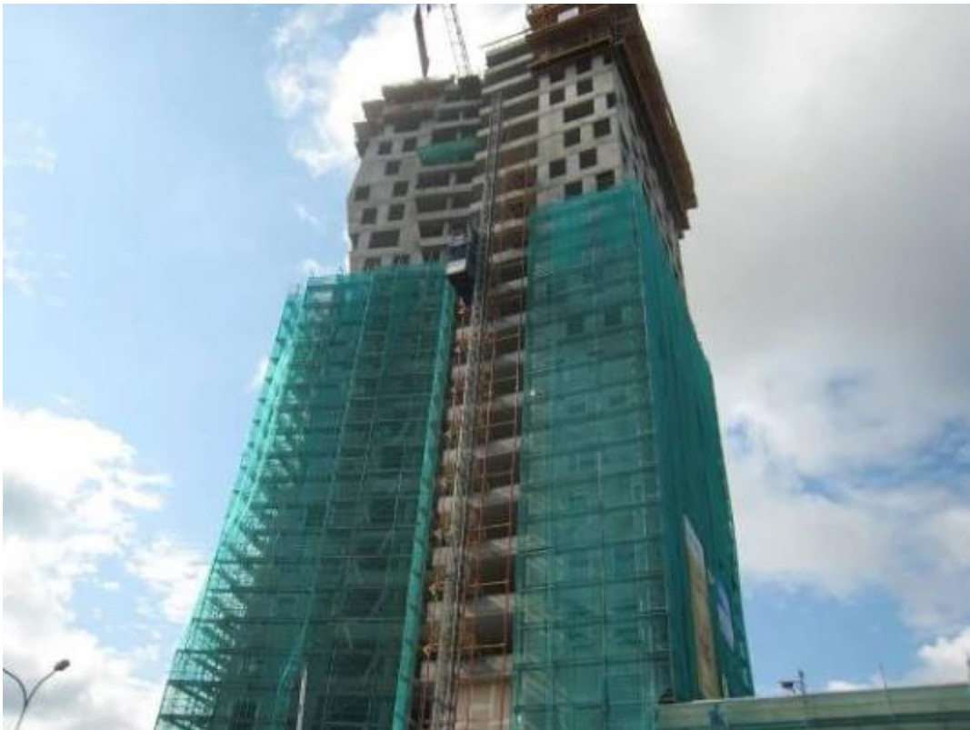
Obrázek 24: Bezpečnostní síť typu U při stavbě AZ Tower v Brně [15]
