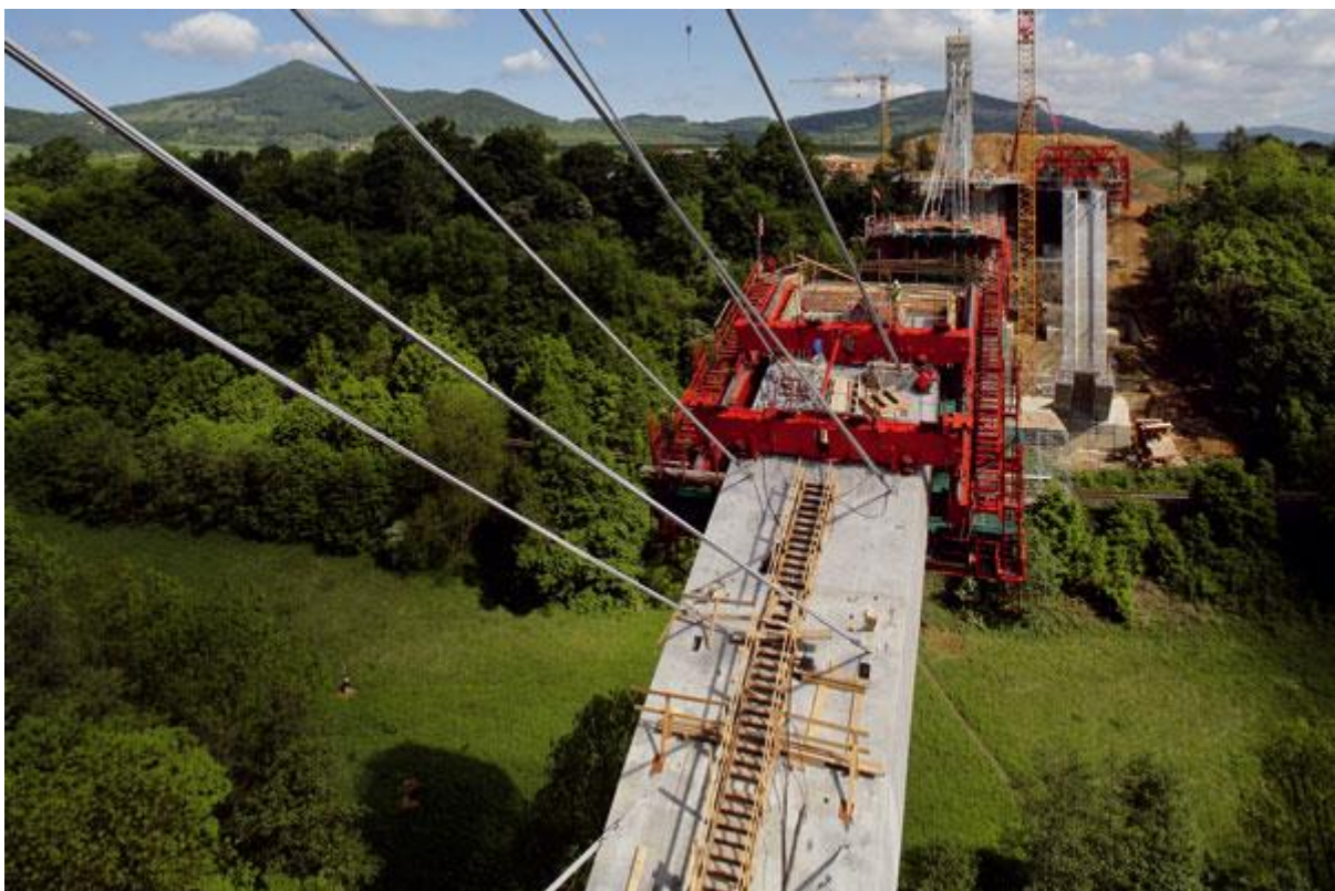
Obrázek 51: Stavba mostu Oparno [22]
