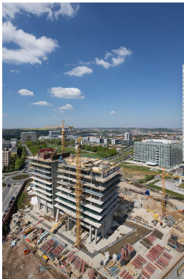
Obrázek 46: Stavba V Tower v Praze [24]
