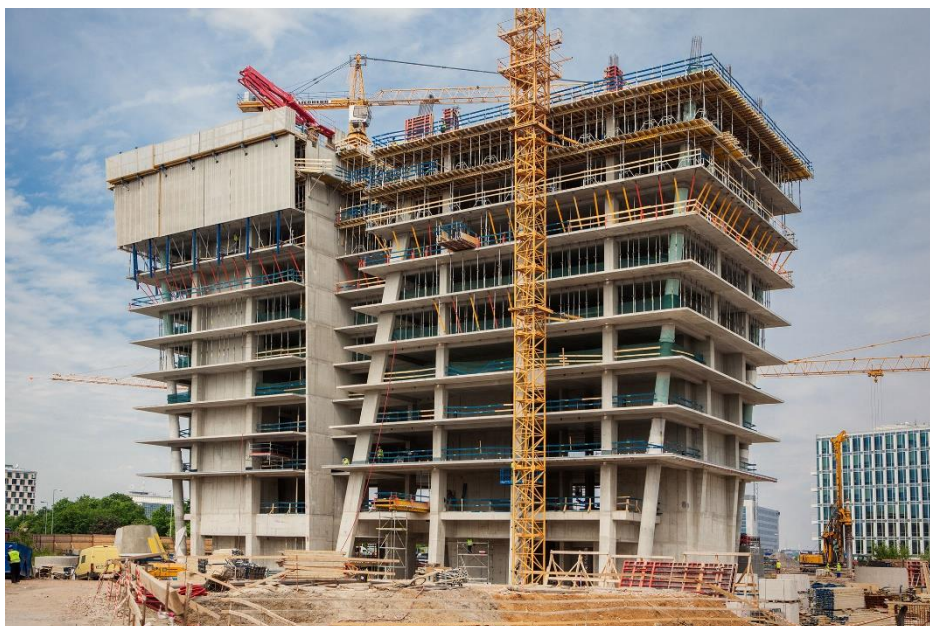
Obrázek 47: Stavba V Tower v Praze [24]
