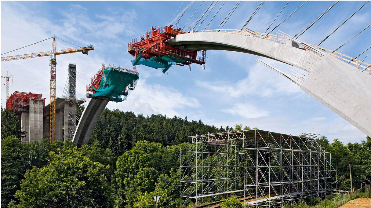
Obrázek 50: Stavba mostu Oparno [21]
