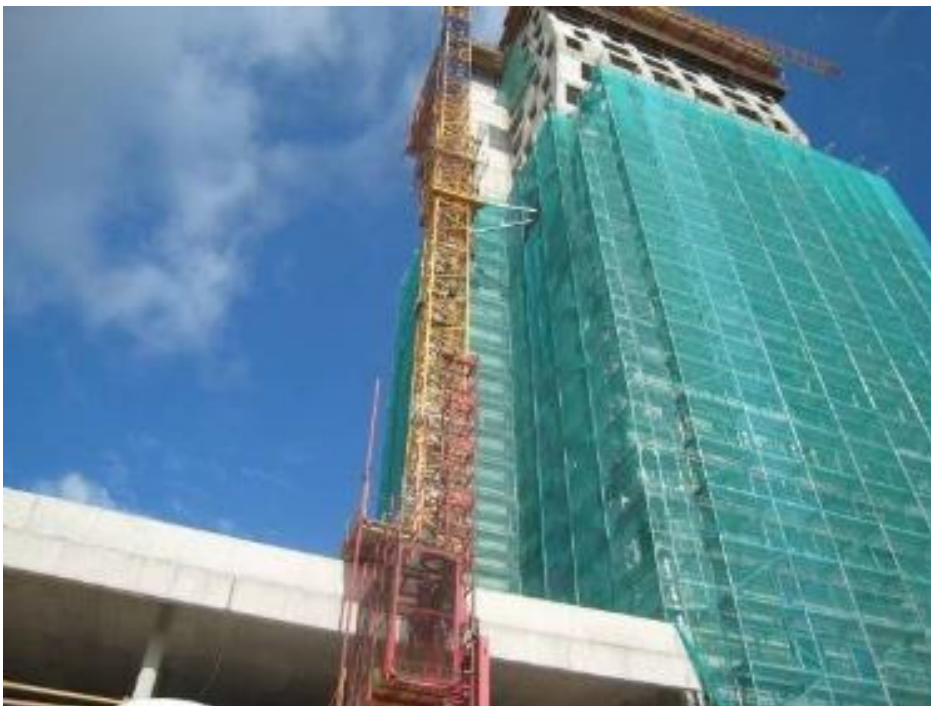
Obrázek 30: Stavba AZ Tower v Brně [15]
