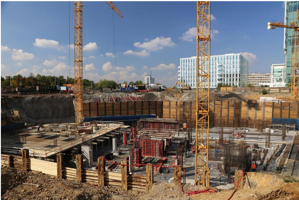
Obrázek 35: Stavba V Tower v Praze [24]
