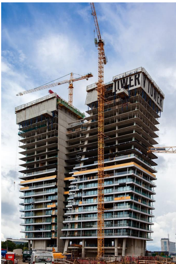
Obrázek 45: Stavba V Tower v Praze [24]
