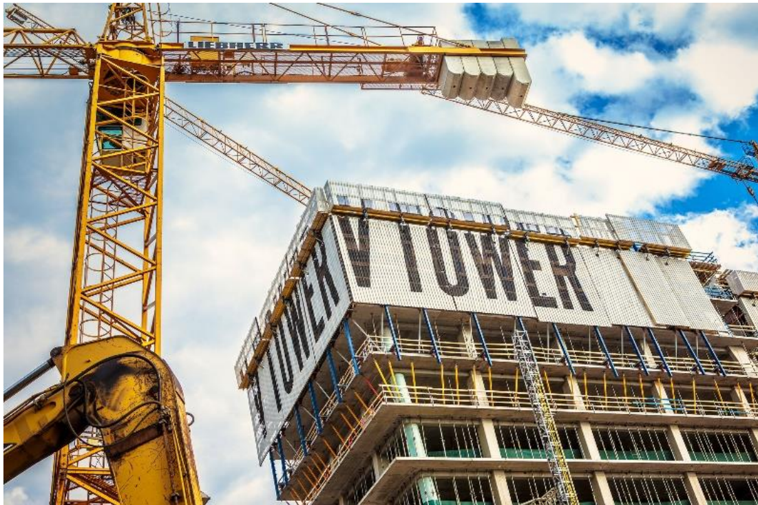
Obrázek 41: Stavba V Tower v Praze [24]
