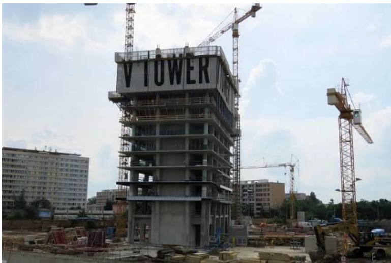
Obrázek 36: Stavba V Tower v Praze [23]
