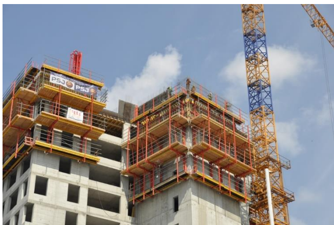
Obrázek 34: Stavba AZ Tower v Brně [18]
