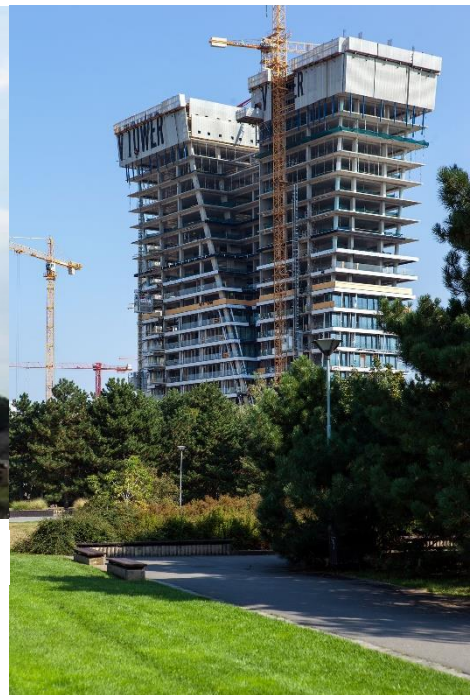
Obrázek 37: Stavba V Tower v Praze [24]
