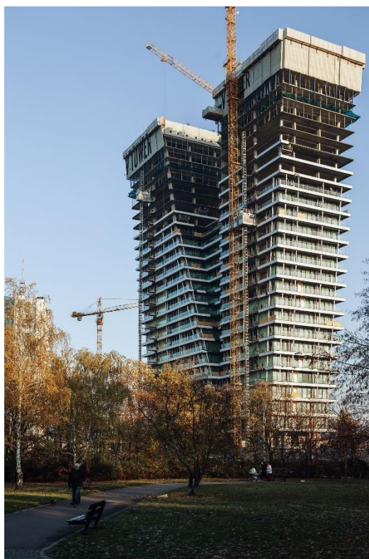
Obrázek 39: Stavba V Tower v Praze [24]
