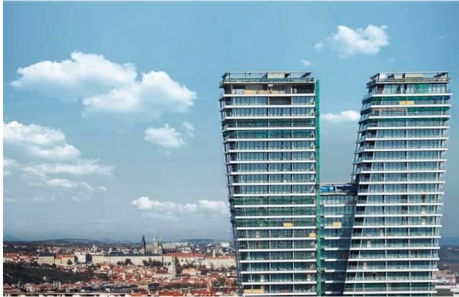
Obrázek 38: Stavba V Tower v Praze [24]
