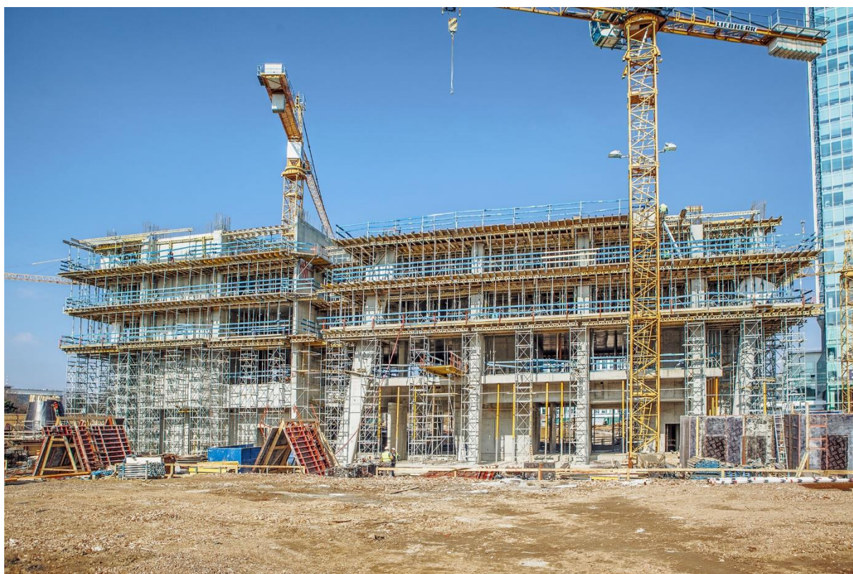
Obrázek 44: Stavba V Tower v Praze [24]
