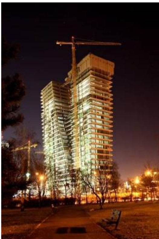
Obrázek 40: Stavba V Tower v Praze [24]
