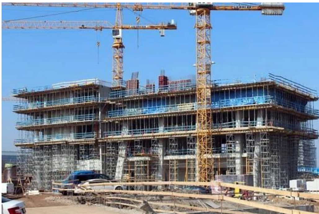
Obrázek 42: Stavba V Tower v Praze [23]
