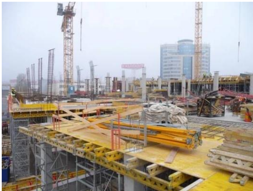
Obrázek 32: Stavba AZ Tower v Brně [16]
