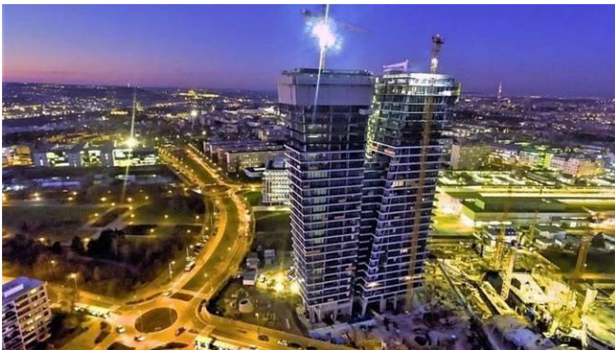
Obrázek 43: Stavba V Tower v Praze [25]
