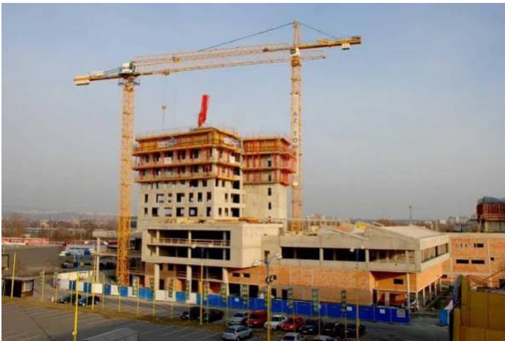
Obrázek 29: Stavba AZ Tower v Brně [14]
