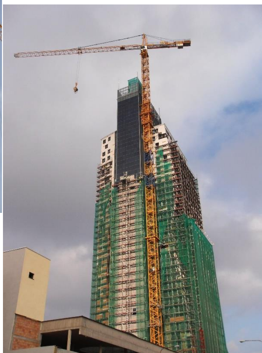
Obrázek 33: Stavba AZ Tower v Brně [17]
