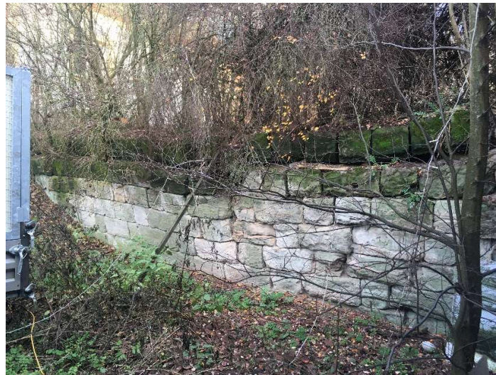
Obrázek 34: Vnější opěrná stěna [vlastní]
