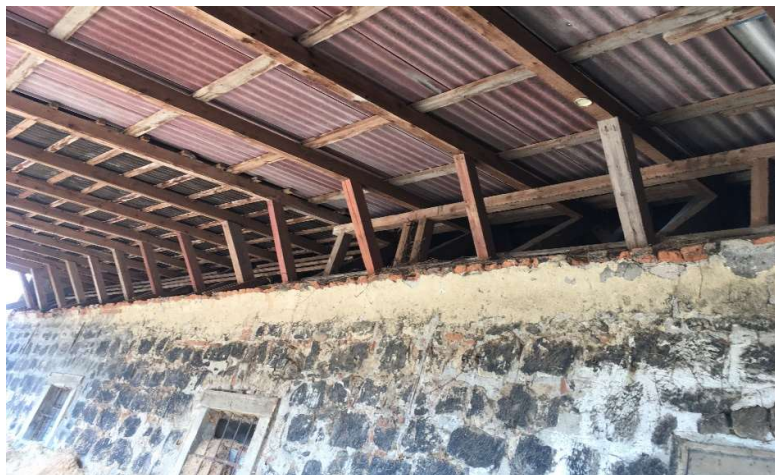
Obrázek 55: Otevřené podkroví do prostoru přístřešku [vlastní]
