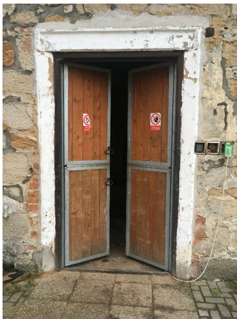
Obrázek 29: Dveře vstupu z plochy z uvaziště [vlastní]
