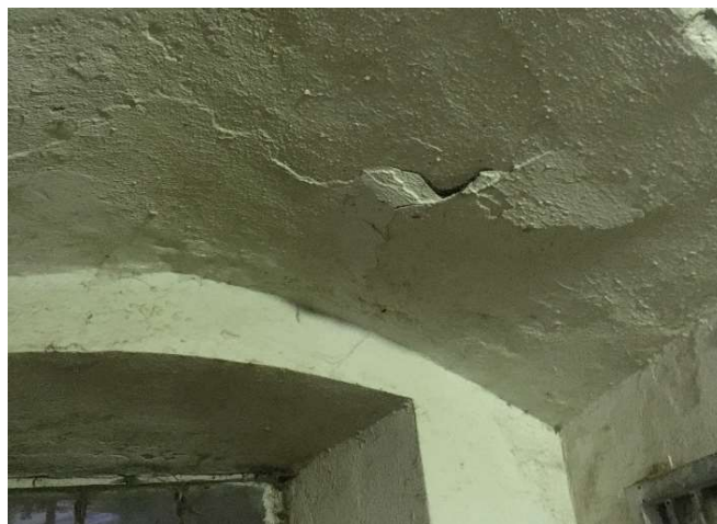
Obrázek 36: Následky nadměrné vlhkosti [vlastní]
