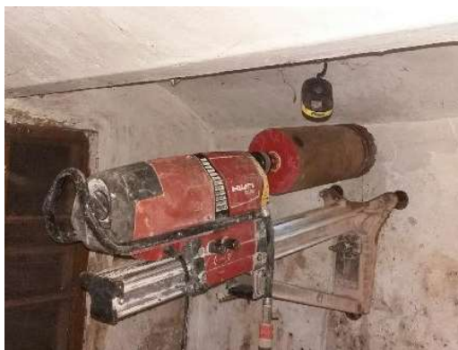
Obrázek 61: Jádrové vrtání [20]
