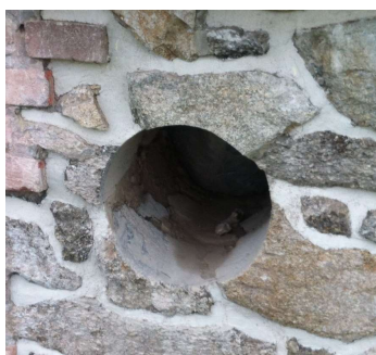
Obrázek 62: Otvor vyvrtaný jádrovým vrtáním do kamenné zdi [20]
