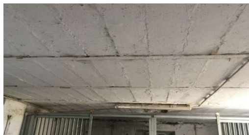
Obrázek 23: Strop nad přípravou [vlastní]
