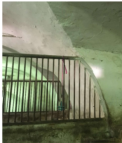
Obrázek 21: Detail příčky mezi boxy s mřížovou nástavbou [vlastní]
