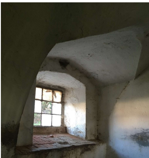
Obrázek 27: Okenní otvor s velkolepým ostěním [vlastní]
