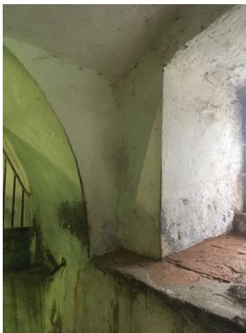
Obrázek 19: Detail klenutí klenby, ostění a části parapetu [vlastní]
