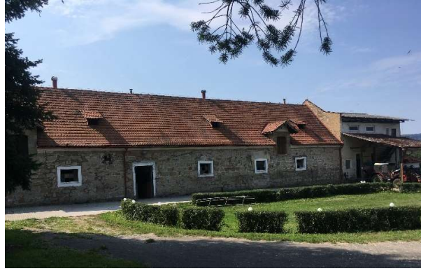
Obrázek 54: Pohled na čelní stranu budovy [vlastní]
