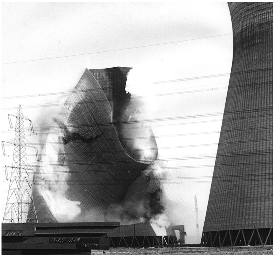
Obrázek 5, zhroutení chladící věže Ferrybridge C, [11]
