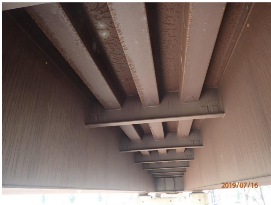
Obr. 16 Most pole P2-P1 – stěny komory, podélné výztuhy, konzoly příčníků
