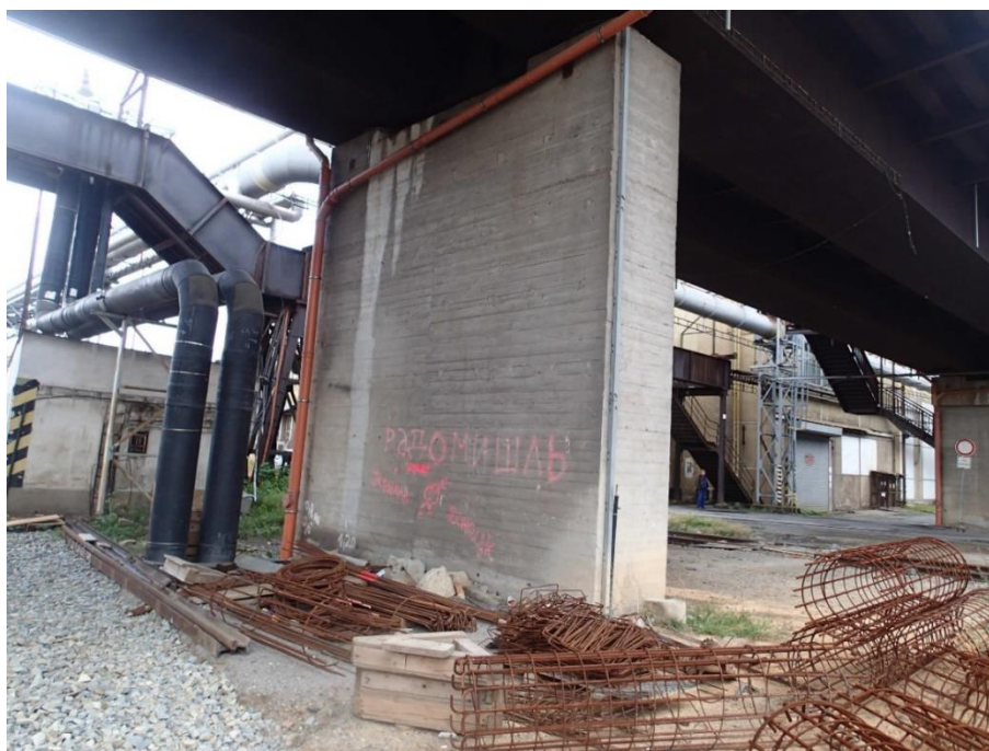
Obr. 21 – Podpěra P2-pohled z jižní strany
