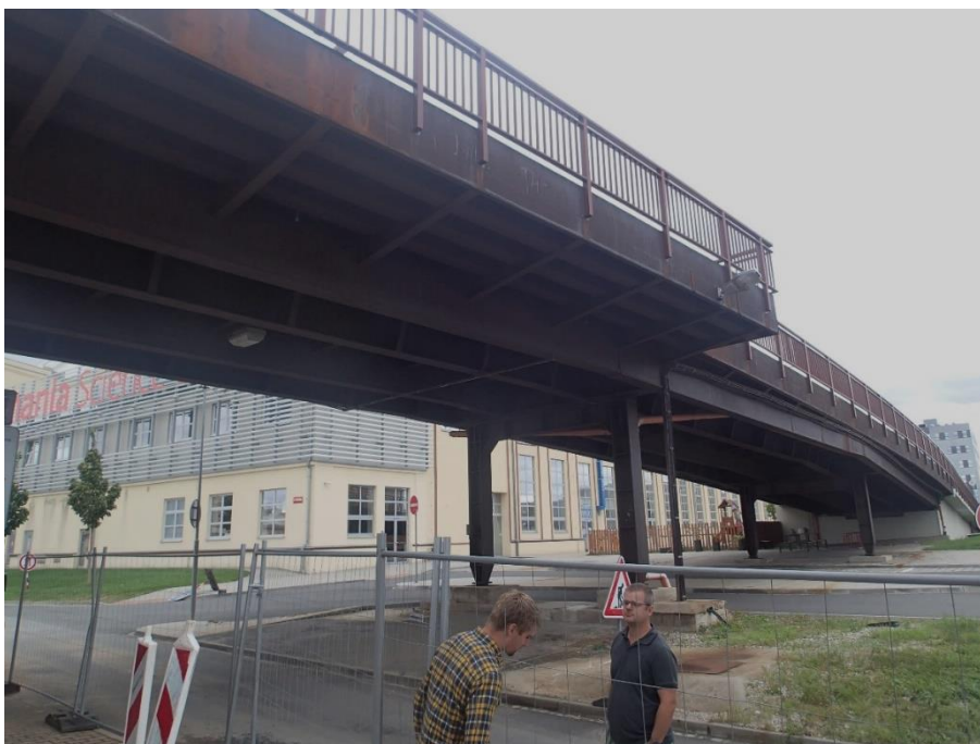
Obr. 5 Jižní nájezd boční pohled (ze západní strany)
