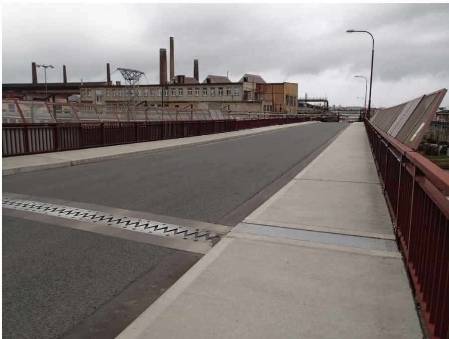
Obr. 14 – Most pohled na vozovku (z jižní strany)
