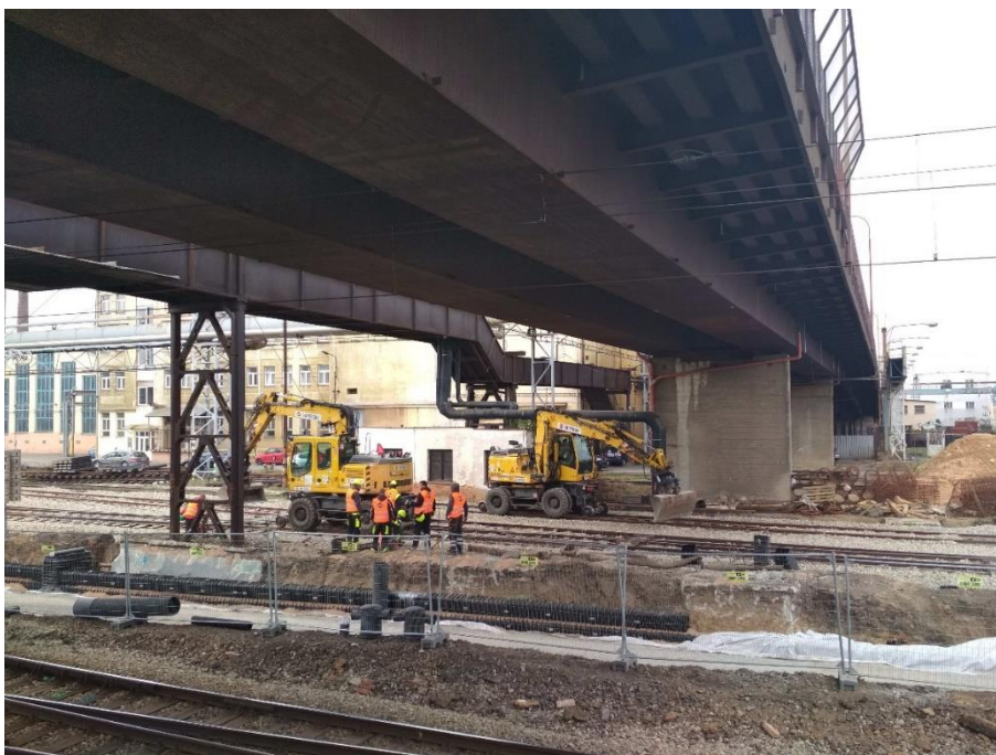
Obr. 15 – Most pohled na hlavní nosníky ( z jižní strany)
