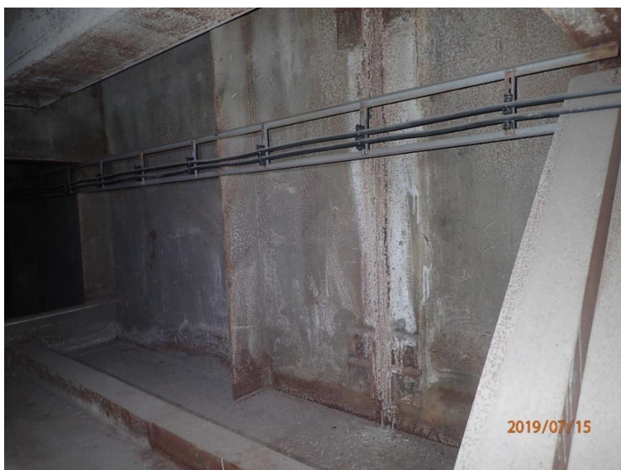
Obr. 17 Most pole P3-P2 – svar stěny komory
