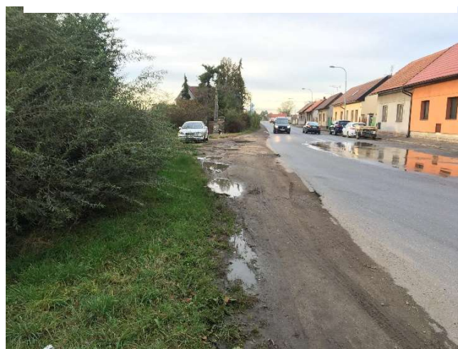
Obr.6 Nebezpečná krajnice bude nahrazena chodníkem pro chodce
