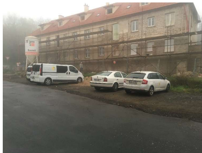
Obr. 6 současný stav parkovacích ploch
