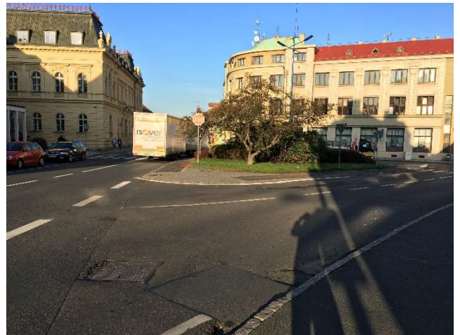
Obr. 6: nevhodný úhel napojení (pohled z V)
