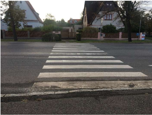
Obr.12 nebezpečně dlouhý přechod
