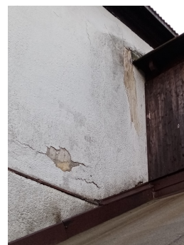
Obr. 37: Napojení dřevěného objektu kolny k hlavnímu objektu
