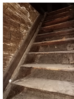
Obr. 14: Žebříkové schodiště do podkrovní
