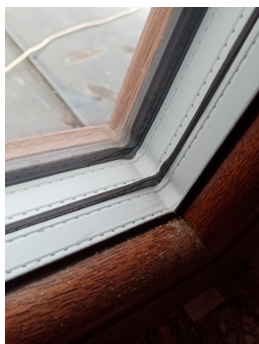
Obr. 23: Detailní pohled na nová okna
