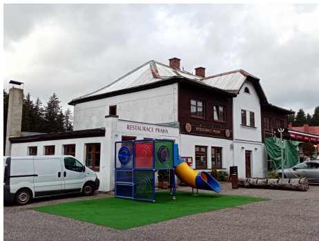
Obr. 8: Pohled jihovýchodní s jednopodlažní jídelnou určenou k demolici
