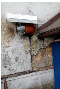
Obr. 36: Výfuk odpadního vzduchu z kuchyně
