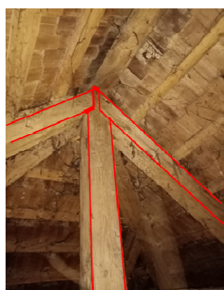
Obr. 20: Spoj věšáku a krokví
