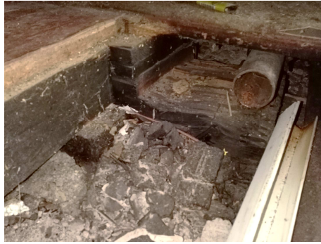
Obr. 41: Pohled na odkrytý záklop stropních trámů
