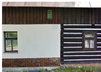
Obr. 3: Kombinovaná fasáda zděné a roubené části
