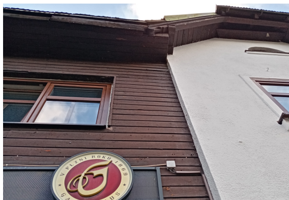
Obr. 32: Přechod dřevěného obkladu a vápenné omítky
