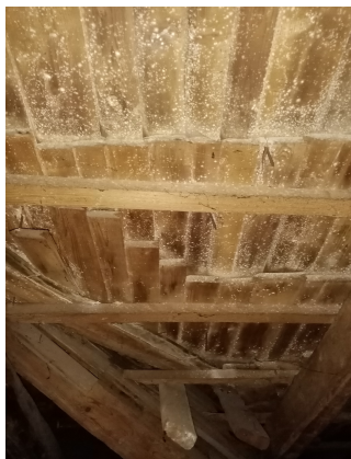
Obr. 18: Pohled na původní šindele z podkroví
