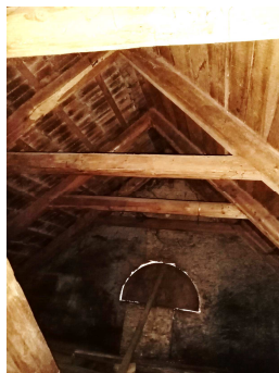
Obr. 22: Konstrukce krovu arkýře
