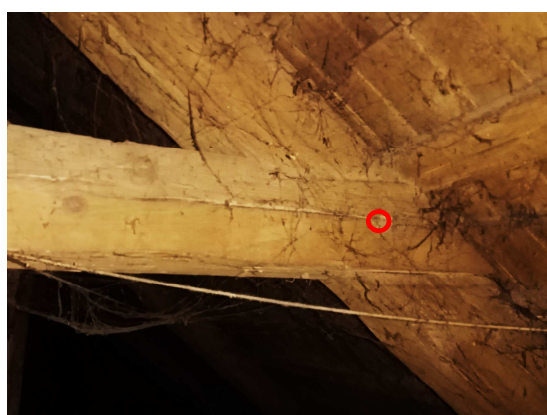
Obr. 21: Ukázka spojení hambálku a krokve
