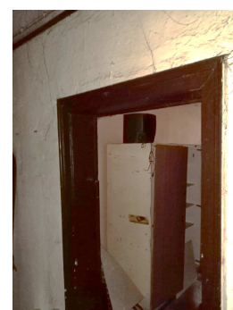
Obr. 28: Interiérové masivní dřevěné zárubně
