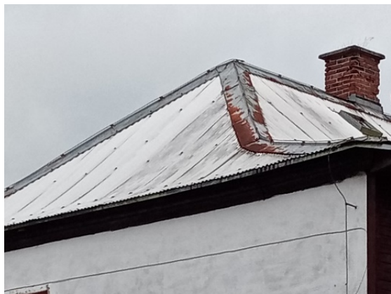
Obr. 19: Pohled na plechovou krytinu
