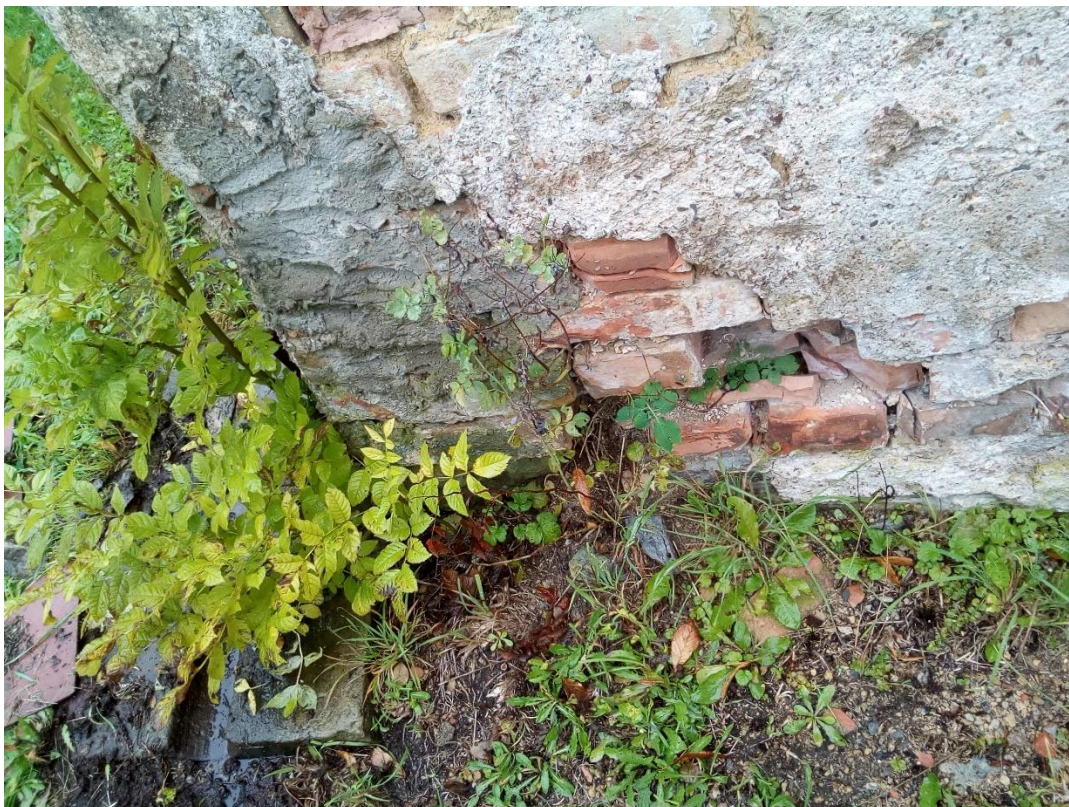
Obrázek 15: Východní kout farní budovy – patrná výrazná biodegradace (Foto autor)
