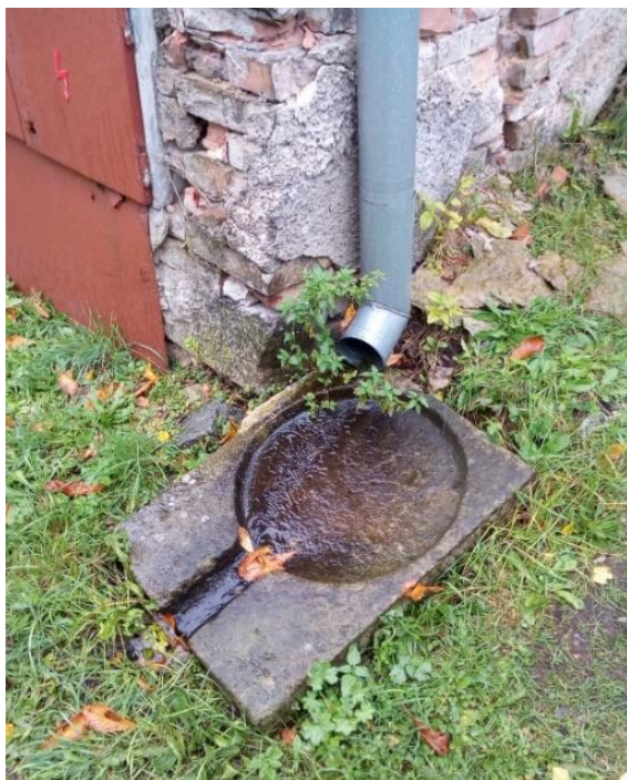
Obrázek 10: Okapový svod s usměrněným odtokem dešťové vody na severním rohu farní budovy (Foto autor)
