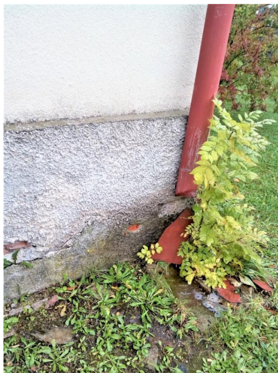
Obrázek 13: Okapový svod bez spodního kolena na východním rohu farní budovy (Foto autor)
