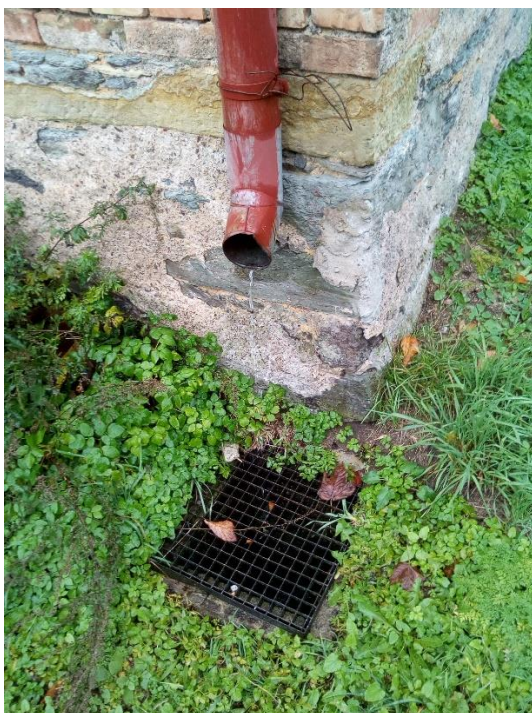
Obrázek 20: Funkční okapový svod na západním rohu farní budovy (Foto autor)
