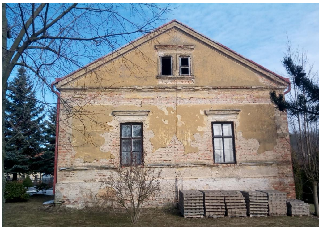
Obrázek 7: Jihozápadní štít farní budovy (Foto autor)
