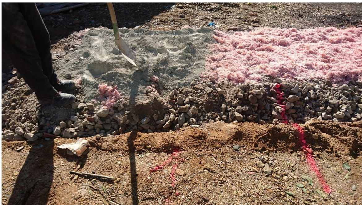
Aplikace cementu na rozprostřená vlákna
