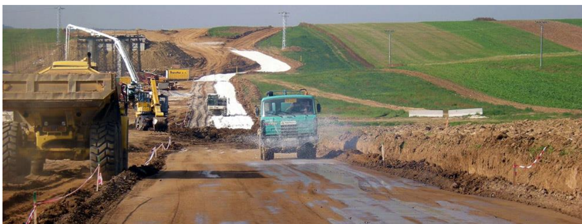
Obrázek 11 – Postup stabilizace vrstvy vozovky [31]
