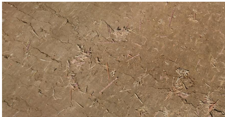
Detail zhutněné vrstvy
