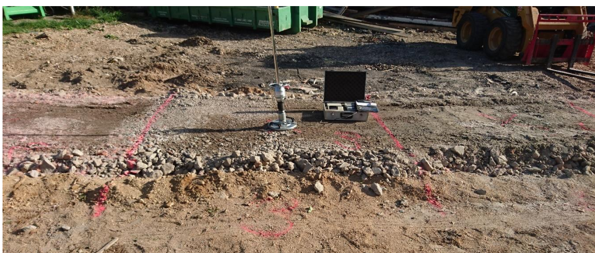
Měření únosnosti dílčího úseku 2/3
