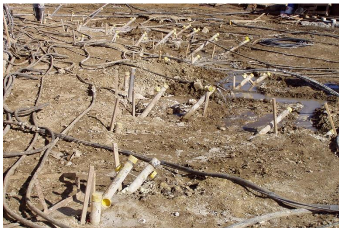
Obrázek 14 - Kompenzační injektáž SOILFRAC [33]
