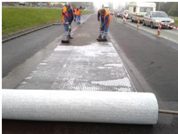
Obrázek 9 - Pokládka geosyntetik [29]
