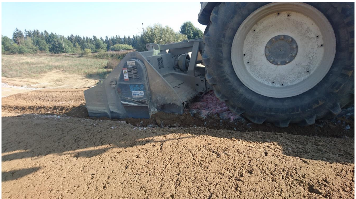
Zpracování vláken do zeminy frézou
