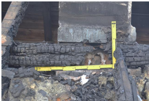
obr. 57: Pohled na středovou vaznici procházející komínovým tělesem
