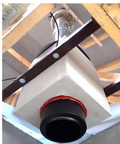
obr. 17: Prostory kovových komínů hořlavou stavební konstrukcí: a) stropní/stěnová průchodka z pěnového skla 8 ; b) průchodka z vermikulitu 9 ; c) komínová šachta z kalcium silikátu 10
