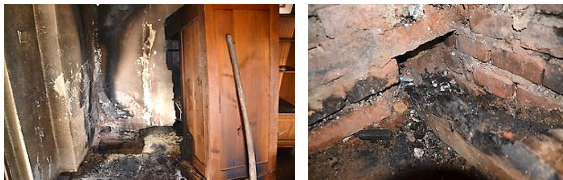
obr. 59: Pohled na místo požáru: a) pohled do rohu místnosti vlevo od vstupních dveří; b) detail trámu v kapse komínového tělesa
