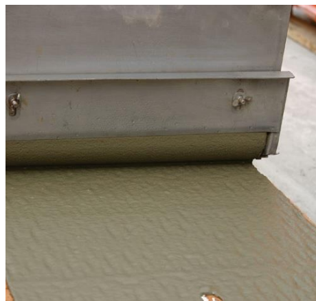
Obr. 3: Výsledná ložná spára [35]
