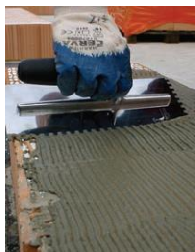
Obr. 4: Nanášení zubovým hladítkem [4]
