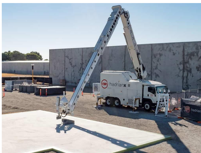
Obr. 27 Hadrian X – umístění cihly na požadované místo [39]
