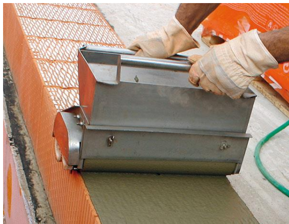
Obr. 2: Aplikace malty pomocí nanášecího válce [34]
