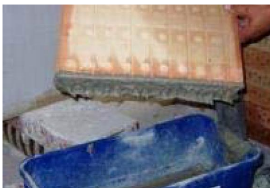
Obr. 9: Princip namáčení tvárnice [2]
