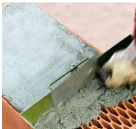
Obr. 14: Nanášení klasické zdící malty do truhlíku [7] Obr. 15: Způsob nanášení malty [7]
