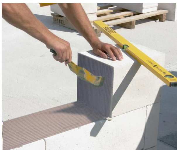
Obr. 5: Nanášení zubovou lžící [4]
