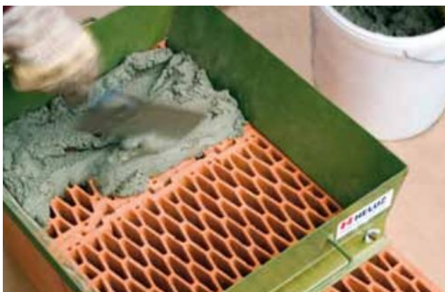
Obr. 14: Nanášení klasické zdící malty do truhlíku [7] Obr. 15: Způsob nanášení malty [7]
