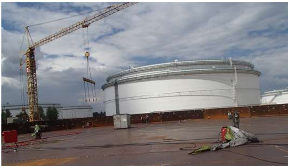
Obrázek č. 27 - dno Nádrže vzorového objektu 4
