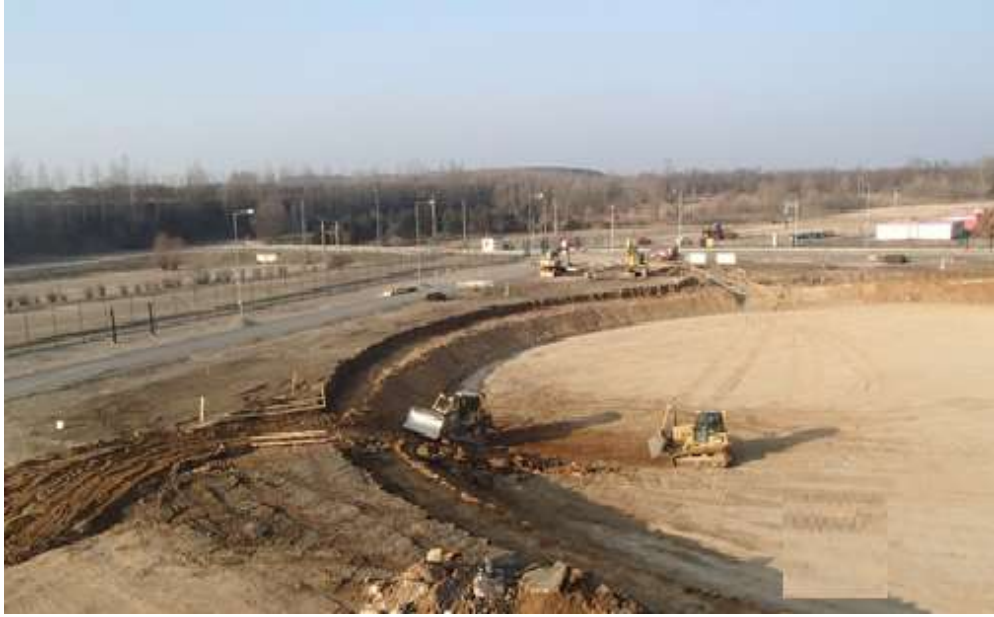
Obrázek č. 24 - výkop jámy pro vzorový objekt 4
