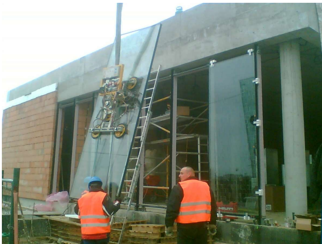
Obrázek č. 8 - montáž velkorozměrových skel vzorového objektu 1
