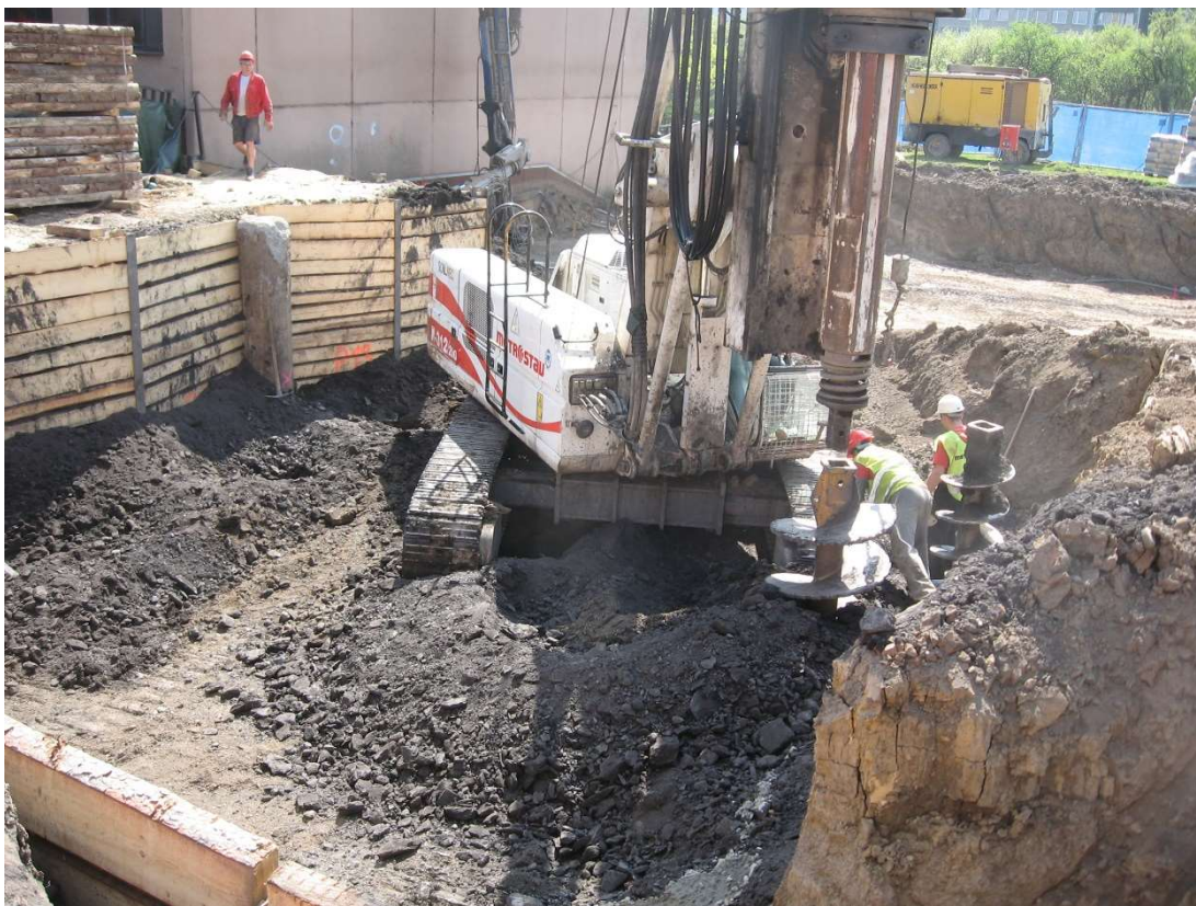
Obrázek č. 11 - provádění základů vzorového objektu 2
