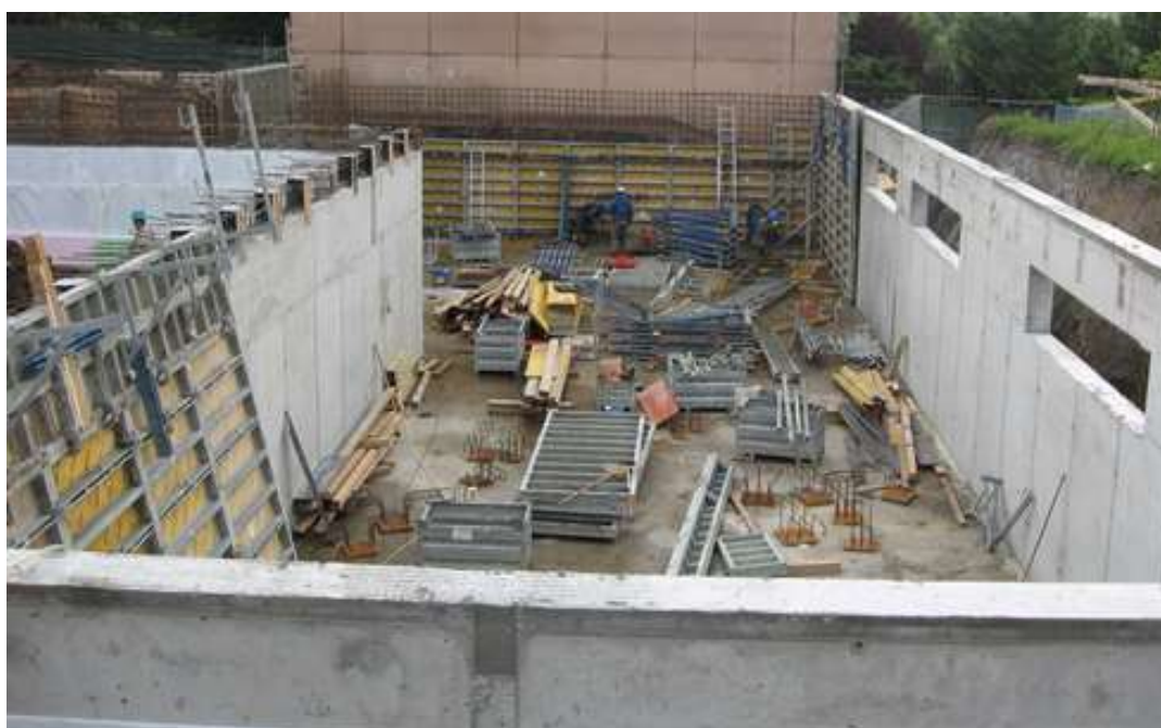
Obrázek č. 13 - provádění ŽB stěn suterénu vzorového objektu 2
