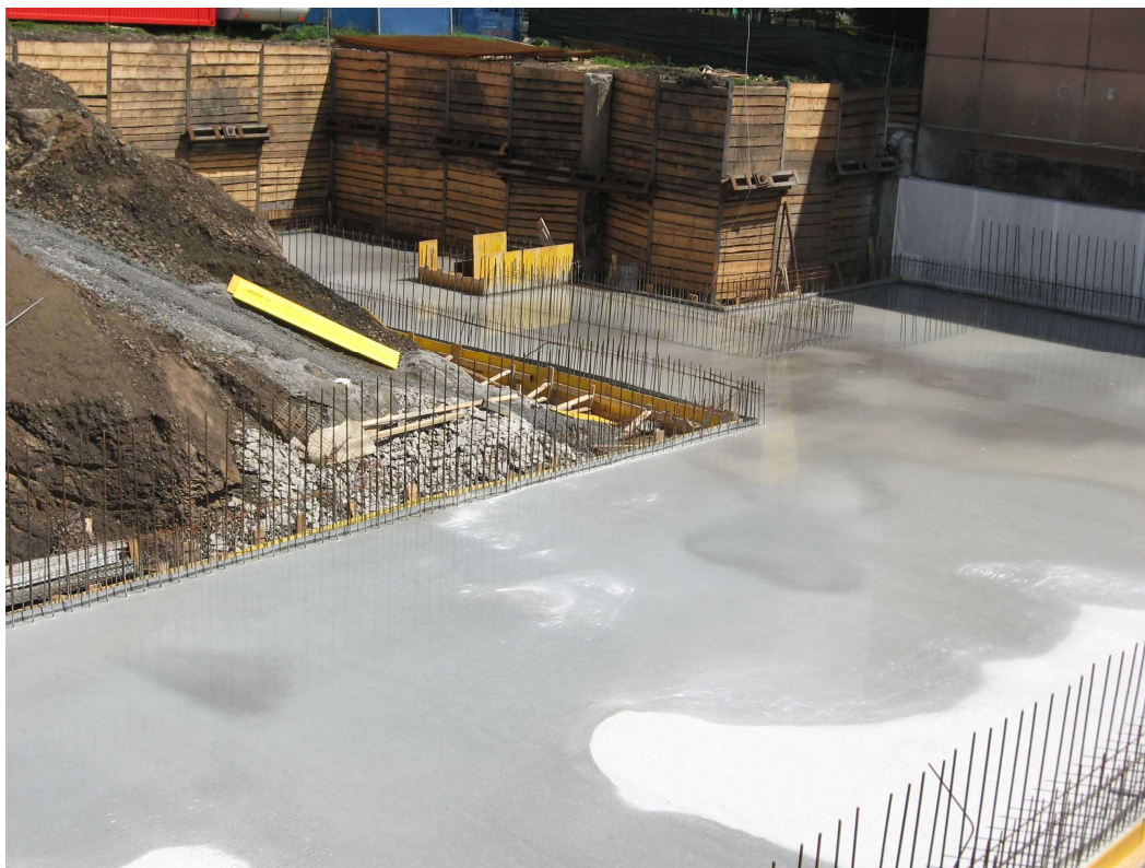
Obrázek č. 12 - hotová základová deska vzorového objektu 2
