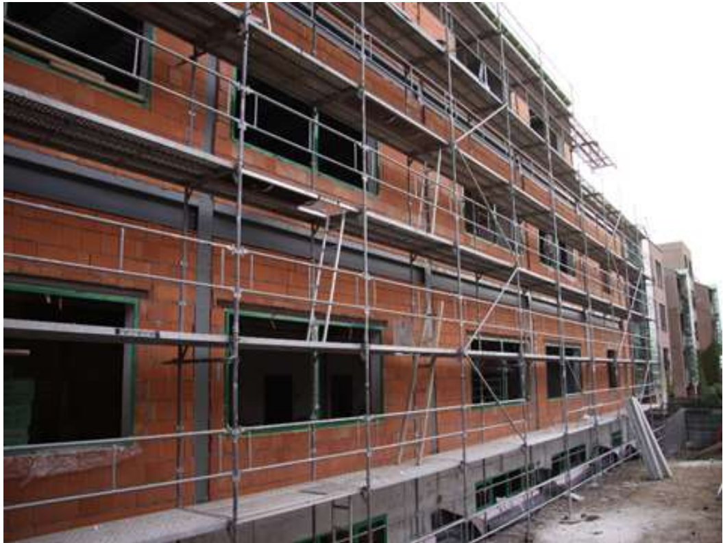
Obrázek č. 16 - vyzdívka obvodového pláště vzorového objektu 2
