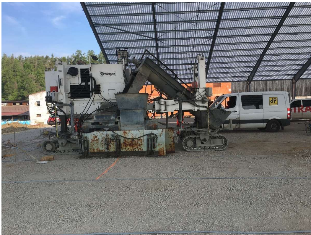
Obrázek č. 20 – provádění vrstev podlahy vzorového objektu 3
