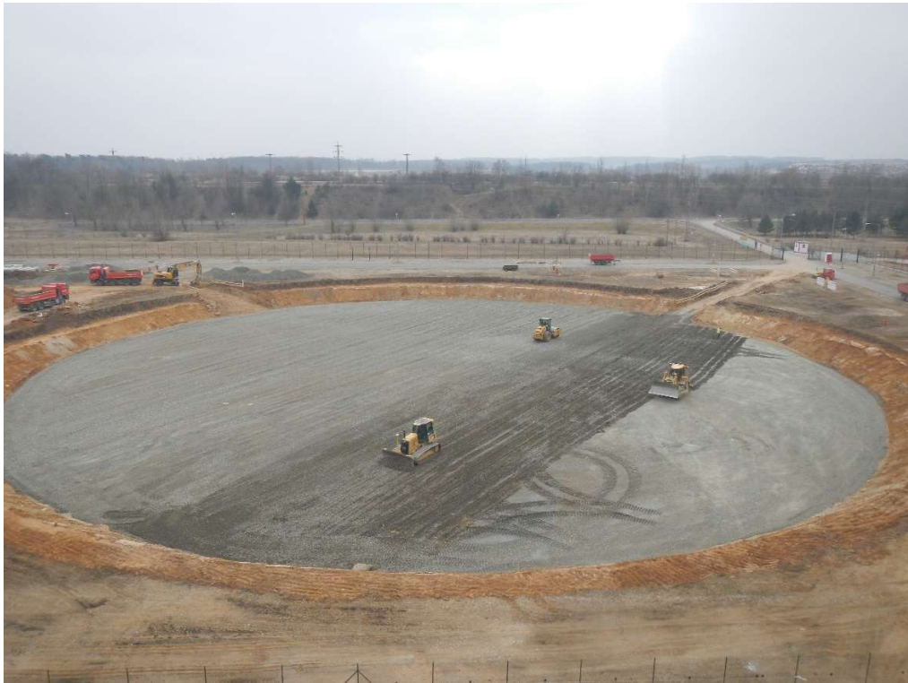
Obrázek č. 25 - podkladní vrstvy vzorového objektu 4
