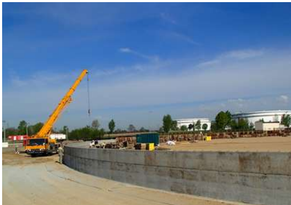
Obrázek č. 26 - ztužující prstenec vzorového objektu 4
