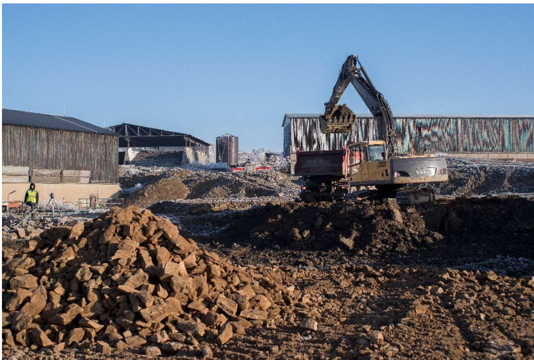
Obrázek č. 19 - provádění výkopových prací vzorového objektu 3
