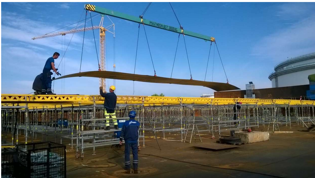
Obrázek č. 29 - skládání plovoucí střechy vzorového objektu 4
