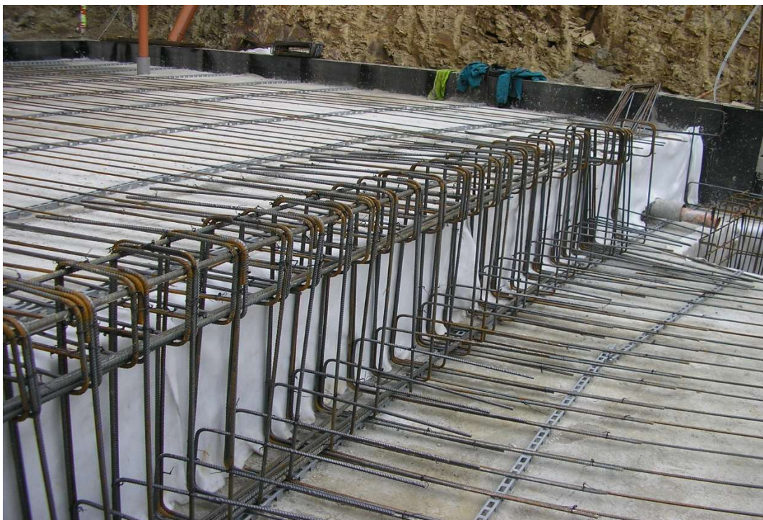
Obrázek č. 7 - vyztužení základové desky vzorového objektu I
