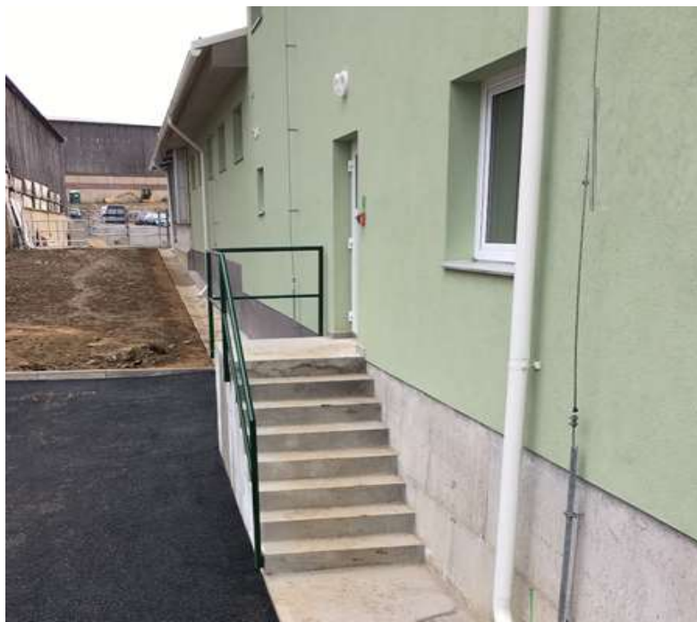
Obrázek č. 22 - fasáda technického zázemí vzorového objektu 4
