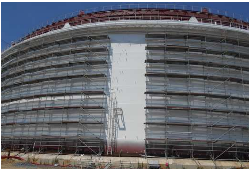
Obrázek č. 30 - provádění nátěrů vzorového objektu 4
