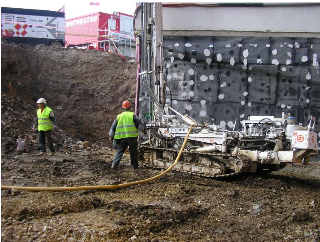
Obrázek č. 6 - založení vzorového objektu 1 na mikropilotech
