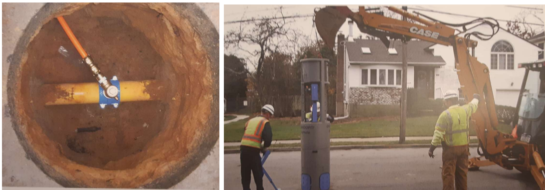
Obrázky č. 8 a 9: Obrázky realizace domovní přípojky IS metodou „keyhole“ [21]
