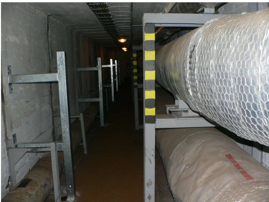
Obrázek č. 14: Fotografie vedení tepla a TUV v kolektoru v areálu FNM
