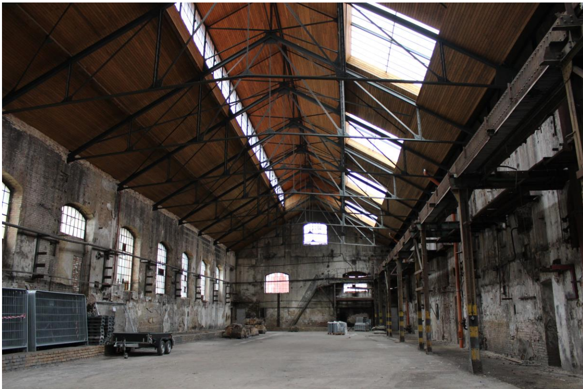
Obr. 48 Interiér bývalé kotelny Garbe, zdroj [9]
