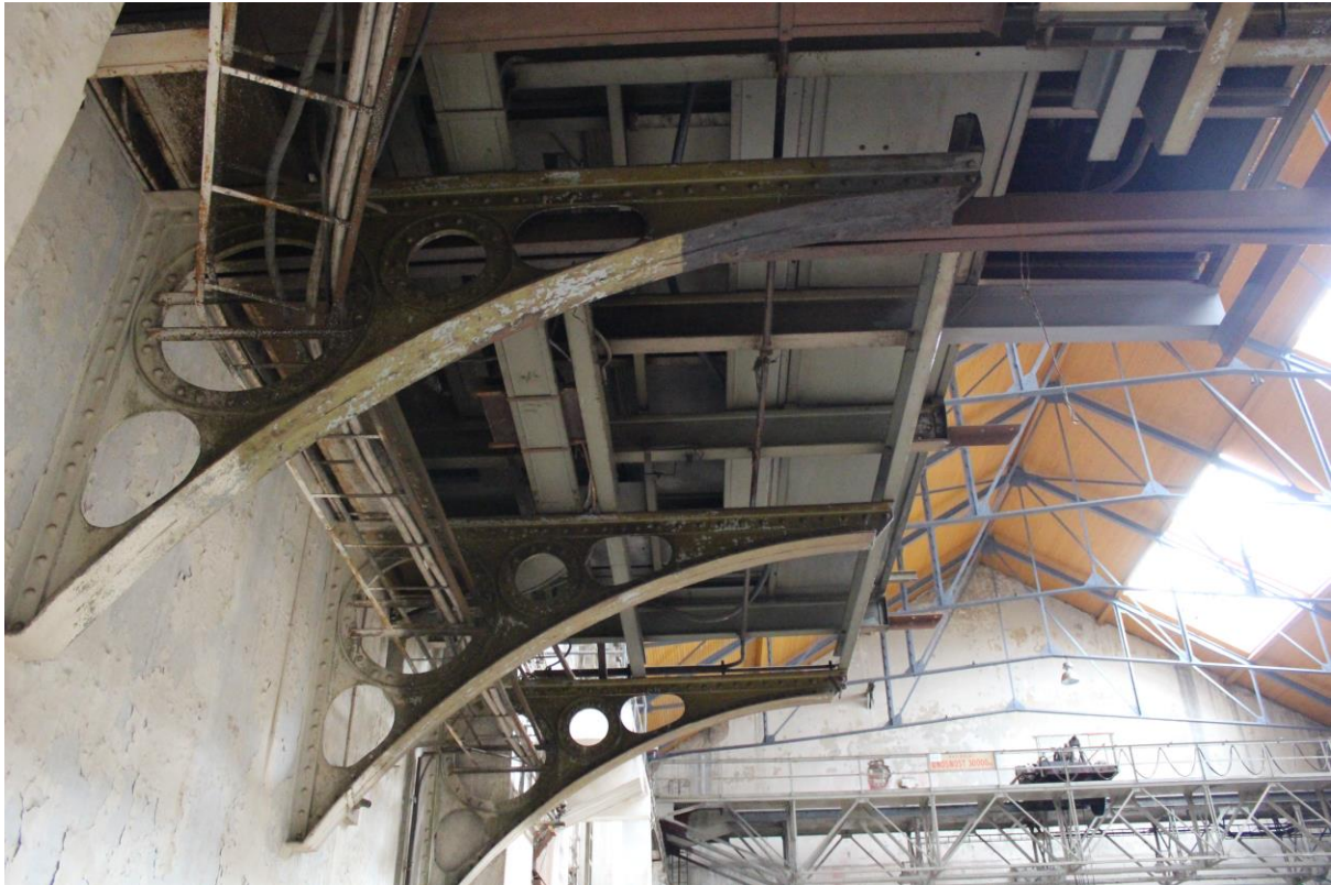
Obr. 74 Nosná konstrukce galerie, příhradové vazníky střechy a mostový jeřáb, zdroj [9]
