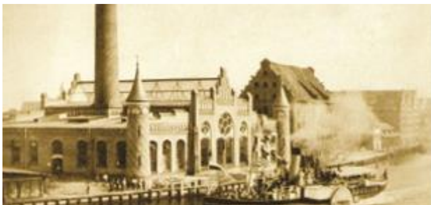
Obr. 1 Historická fotografie elektrárny, zdroj: www.filharmonia.gda.pl
