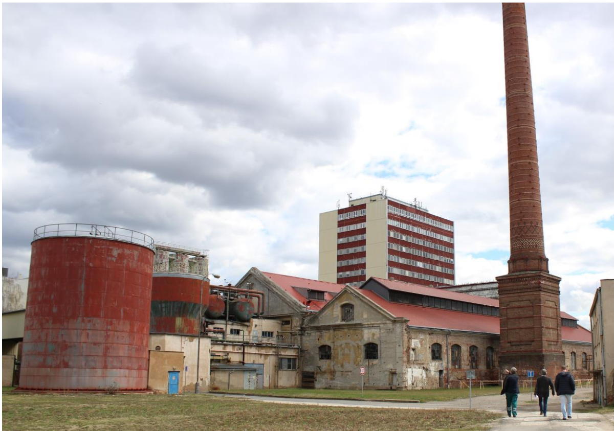
Obr. 50 Severní pohled na elektrárnu a přístavěnou úpravnu vody, zdroj [9]
