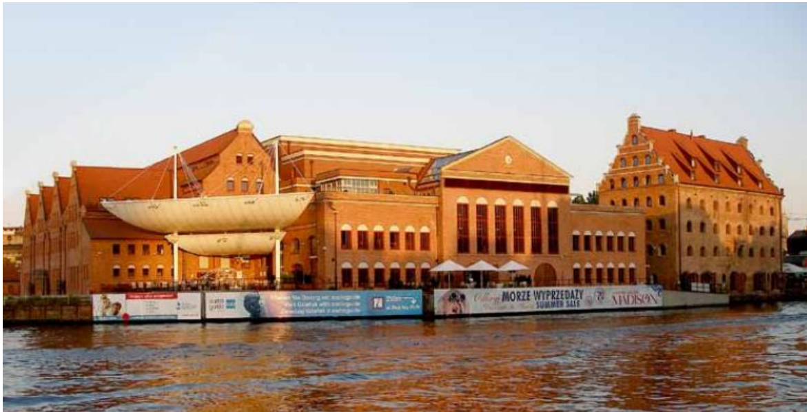
Obr. 2 Západní pohled na filharmonii, zdroj: www.imaterialy.cz
