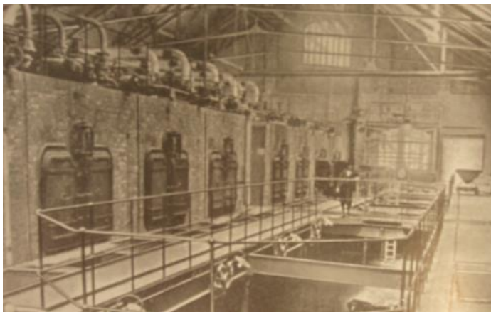
Obr. 36 Interiér kotleny r. 1899, zdroj [9]
