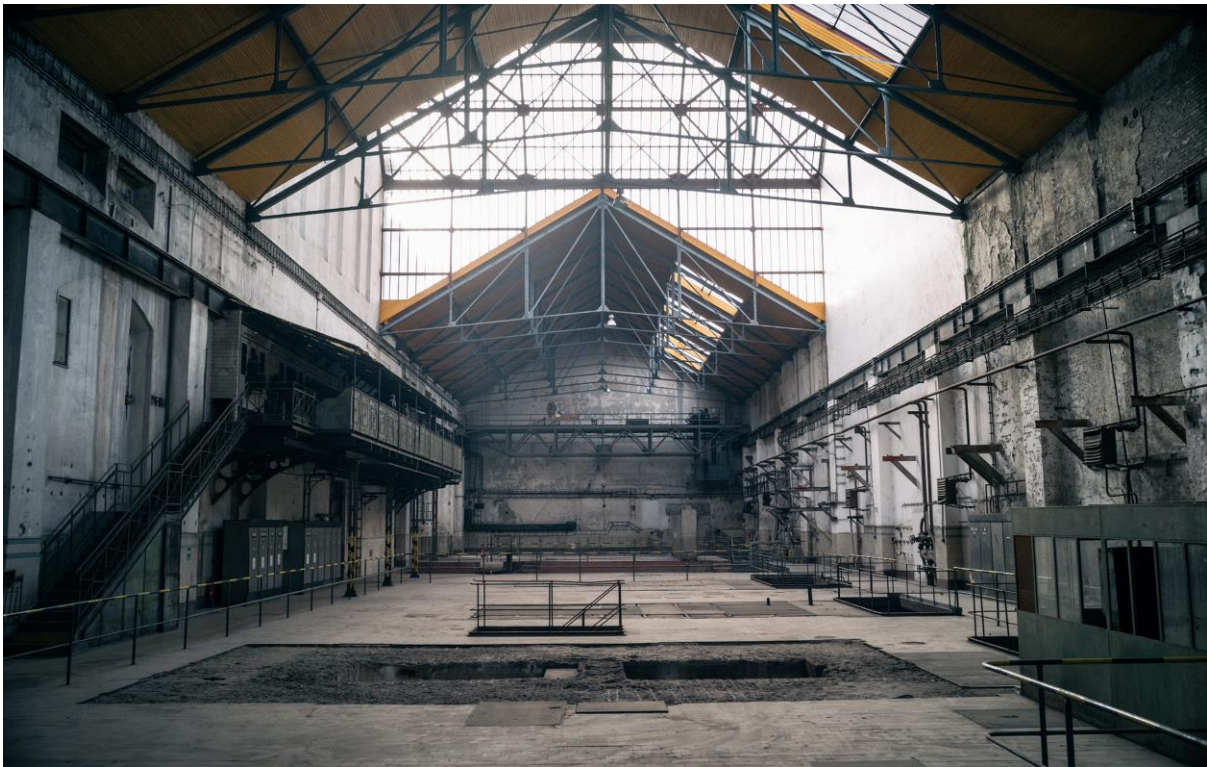
Obr. 41 Jižní strana strojovny s obslužným pultem a prosklenou střechou, zdroj: ww.mistamehomesta.cz
