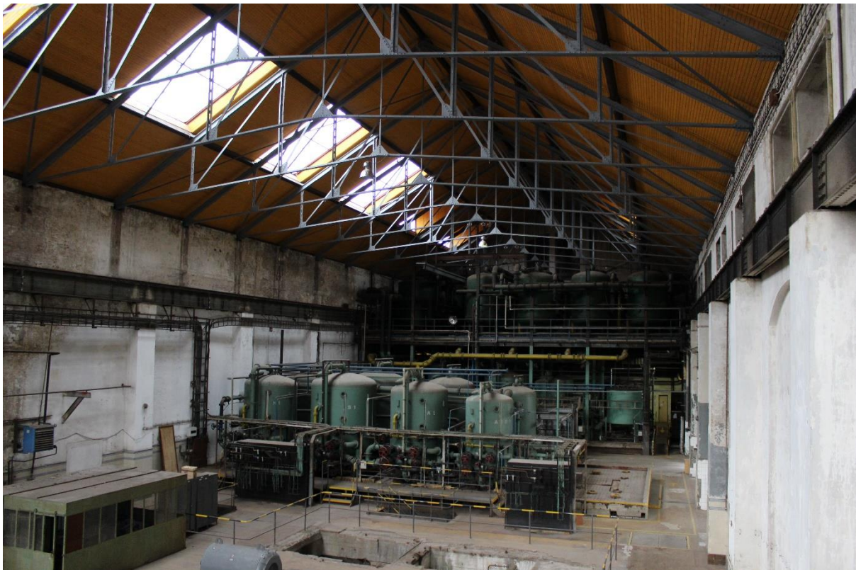
Obr. 40 Severní strana strojovny s úpravnou vody, zdroj [9]
