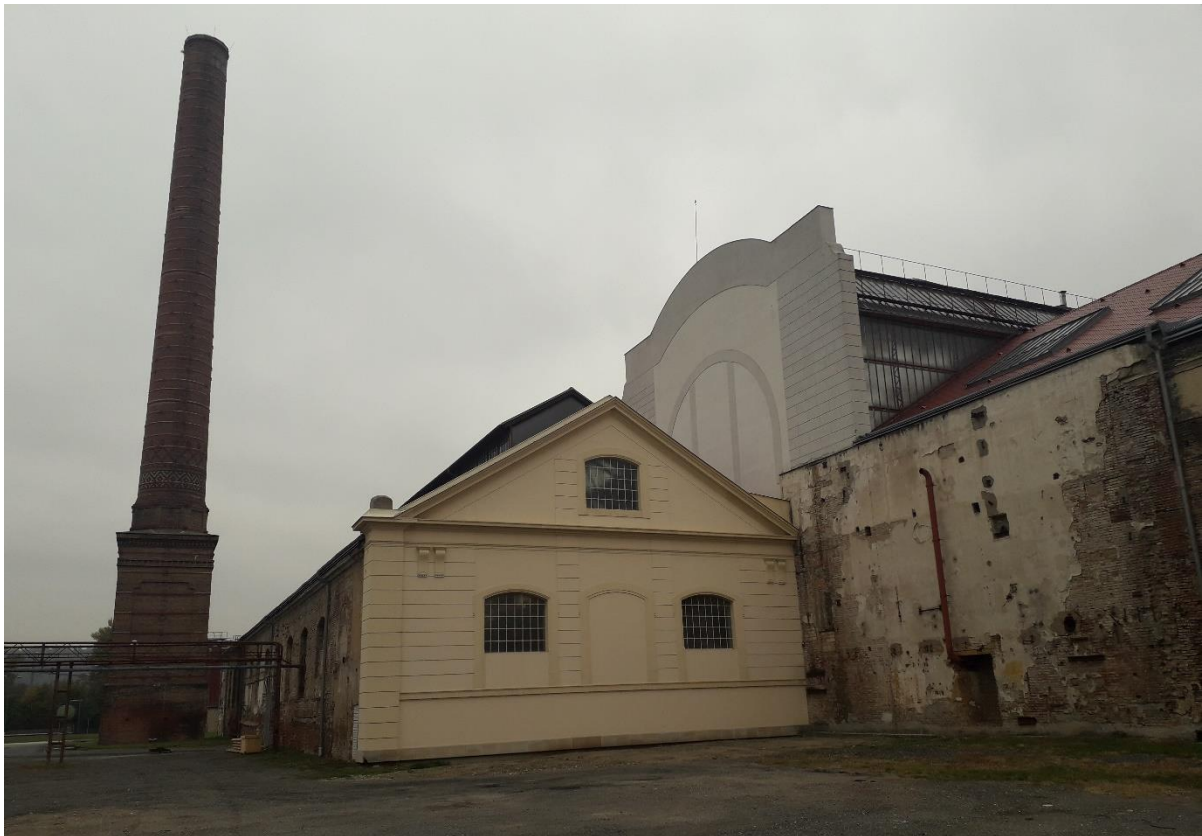
Obr. 49 Jižní pohled na opravené štíty kotelny a strojovny
