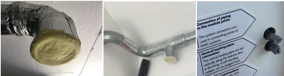
Obrázek 6: Zatěsnění odtahu vzduchu a připravených trubek vytápění
