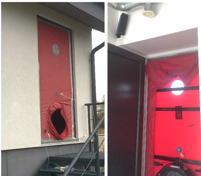
Obrázek 8: Osazený instalační rám ve vchodových dveřích - z exteriéru a interiéru
