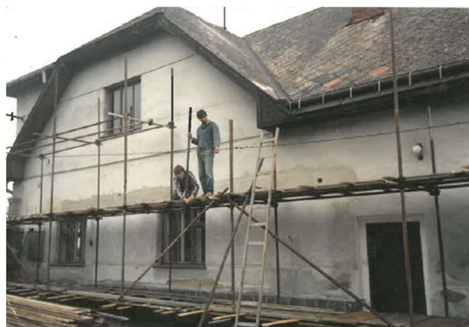
Obrázek 9 – Fotografie z roku 1995 dokumentující renovaci fasády
