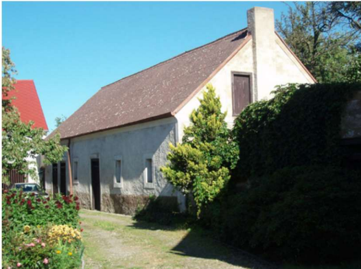
Obrázek 4 – Stavení před rekonstrukcí
