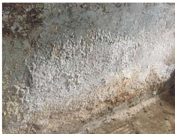
Obrázek 21 – Vlhké a zasolené zdivo určené k průzkumu
