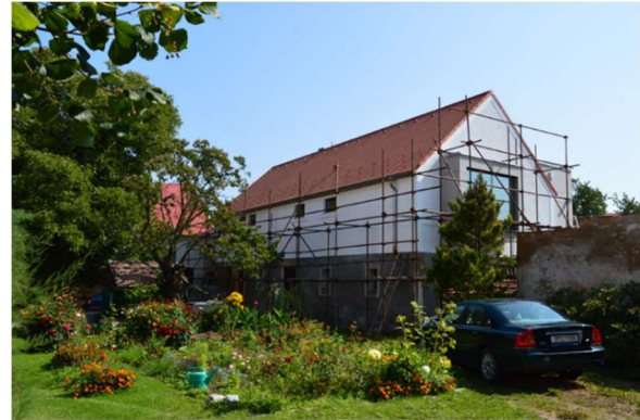
Obrázek 3 – Nástavba rodinného domu při rekonstrukci
