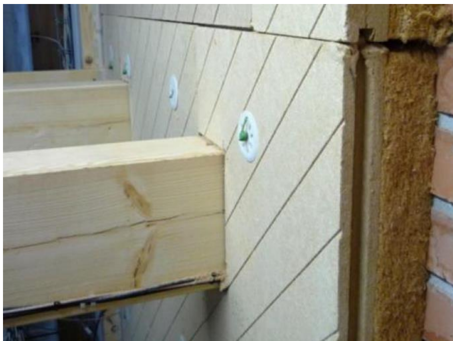
Obrázek 9 - provádění vnitřního zateplení - zdroj [5]
