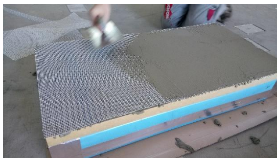
Obr. 42 KVH rám s armovací tkaninou
