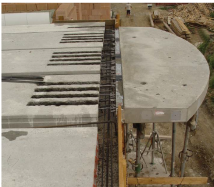
Obr. 6 - Řešení předsazené konstrukce [9]
