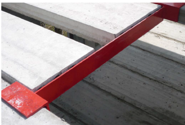
Obr. 7 - Ocelová výměna u prostupu [9]
