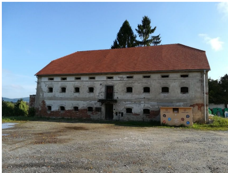
Obr.22 Pohled na jihozápadní fasádu objektu
