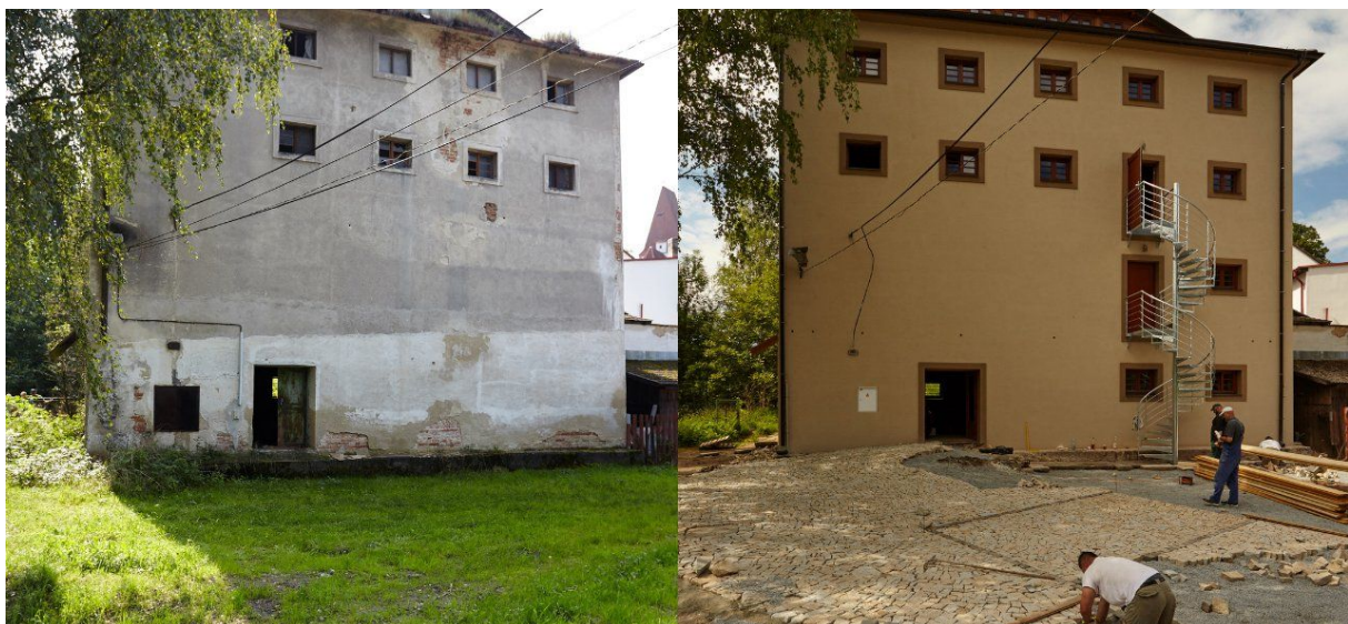
Obr. 01 Sýpka Stropnice, zdroj: http://www.sypka-stropnice.cz/fotogalerie/
