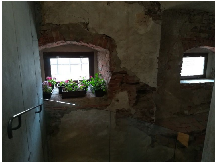
Obr. 17 Schodiště do přízemí
