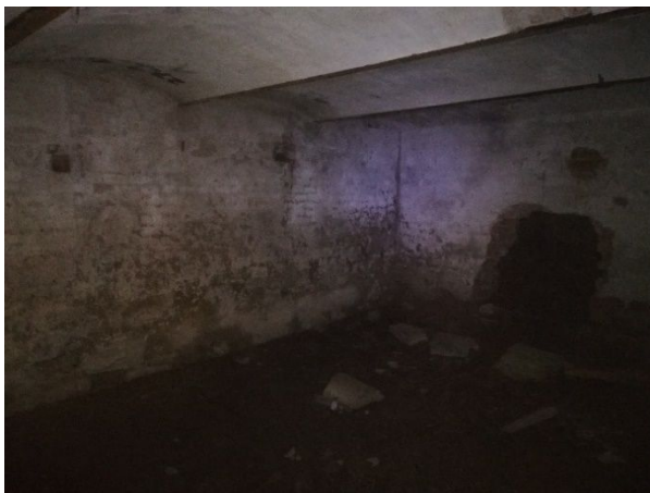
Obr. 23 Strop nad 1.PP
