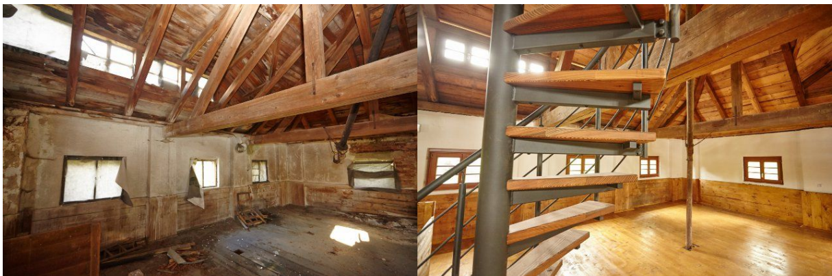
Obr. 06 Sýpka Stropnice, zdroj: http://www.sypka-stropnice.cz/fotogalerie/
