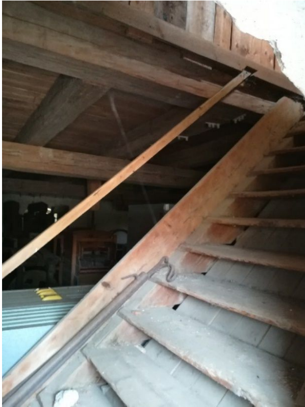
Obr. 25 Schodiště do 2. NP
