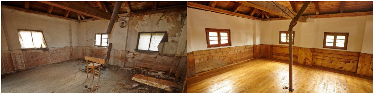
Obr. 04 Sýpka Stropnice, zdroj: http://www.sypka-stropnice.cz/fotogalerie/
