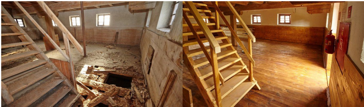
Obr. 03 Sýpka Stropnice, zdroj: http://www.sypka-stropnice.cz/fotogalerie/
