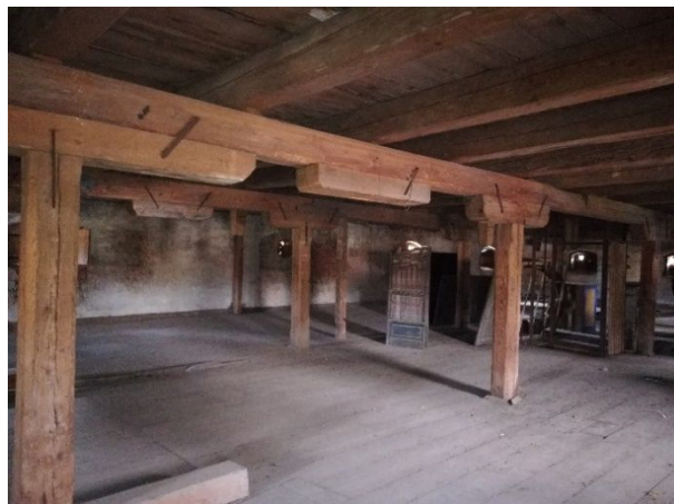
Obr.24 Strop nad 2.NP
