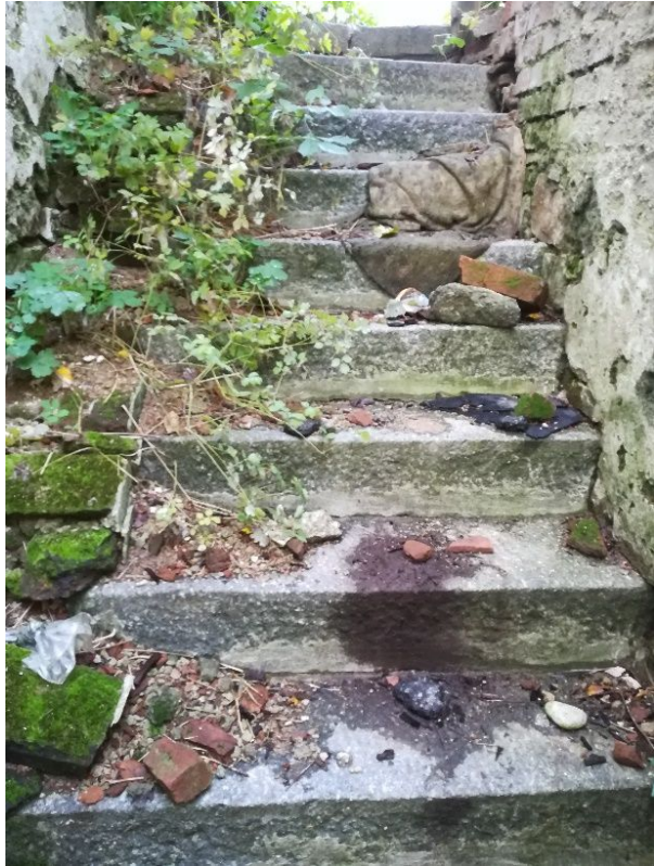
Obr. 26 Schodiště do 1.PP
