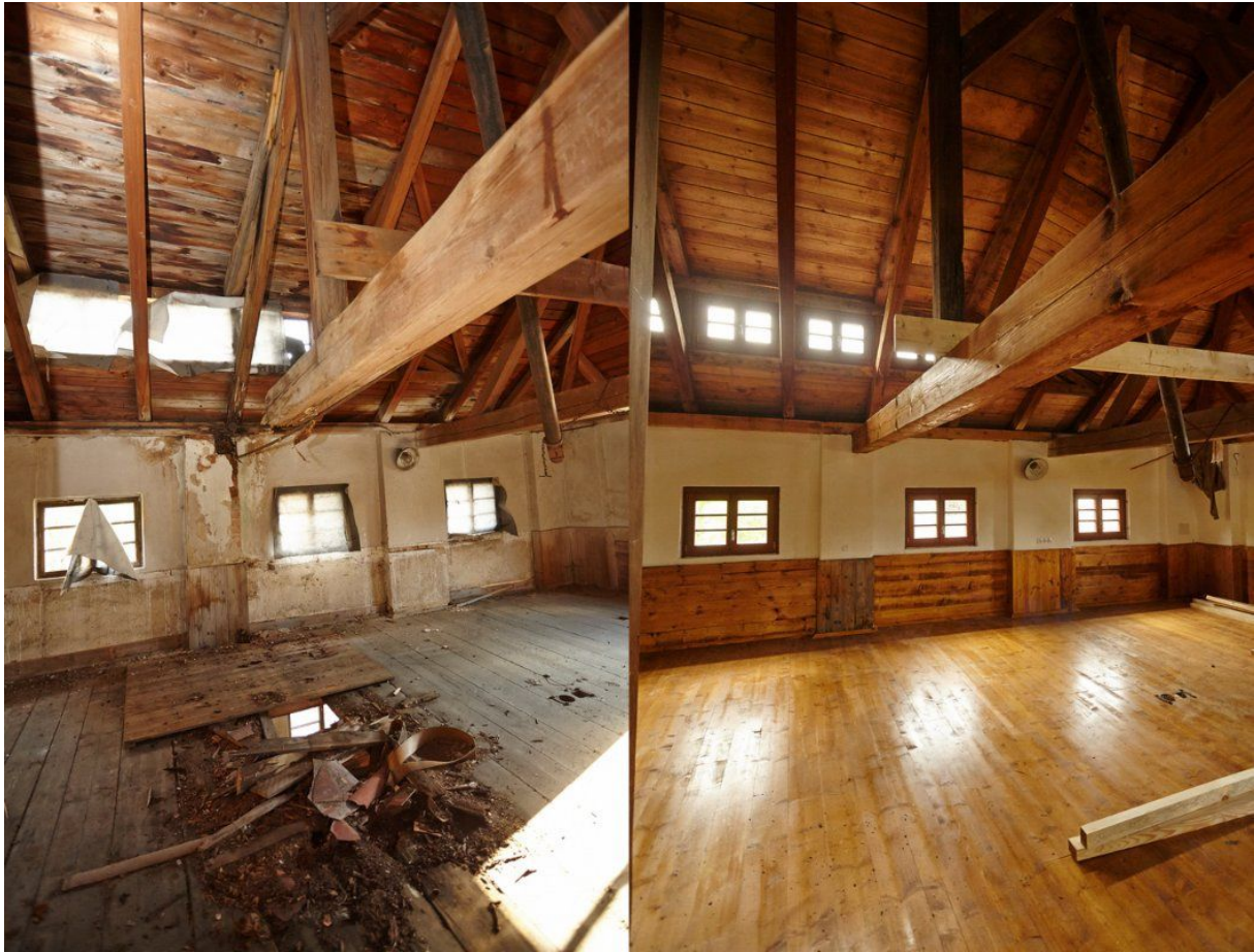
Obr. 05 Sýpka Stropnice, zdroj: http://www.sypka-stropnice.cz/fotogalerie/
