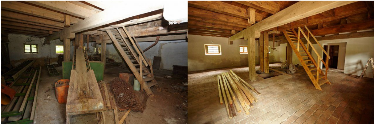
Obr. 02 Sýpka Stropnice, zdroj: http://www.sypka-stropnice.cz/fotogalerie/
