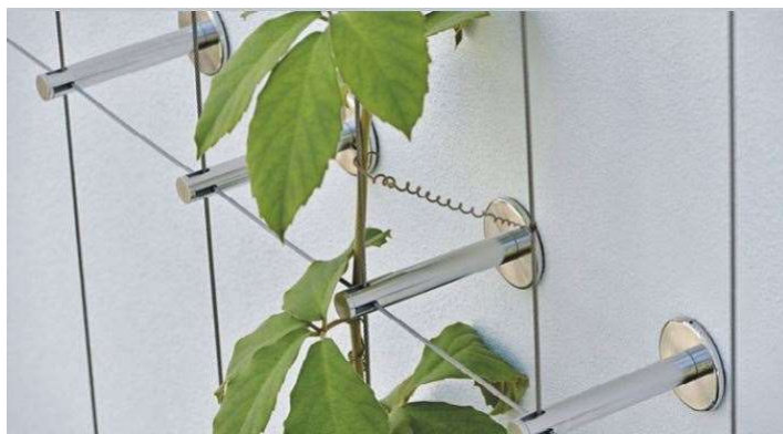
Obr.13 pnoucí zeleň na fasádě ukázka kotvení [6]
