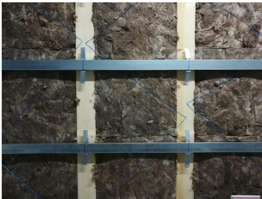
Obrázek 57 - Spodní pohled na „strop 2“ - rošt a závěsy podhledu
