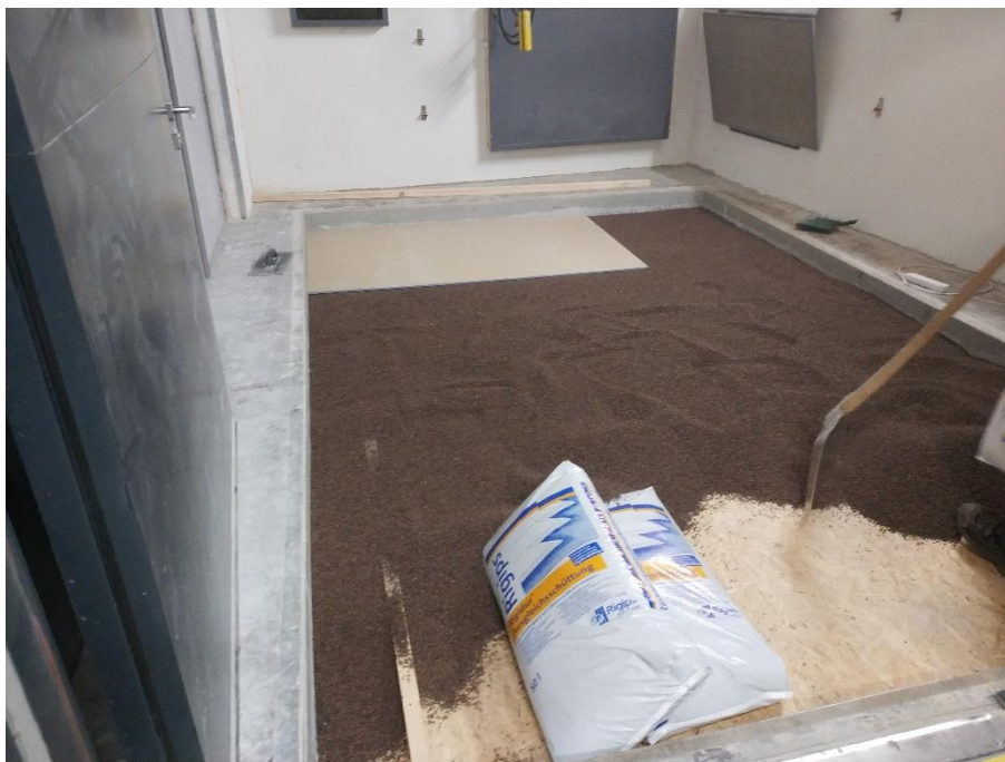
Obrázek 62 - Realizace násypu - „strop 4“
