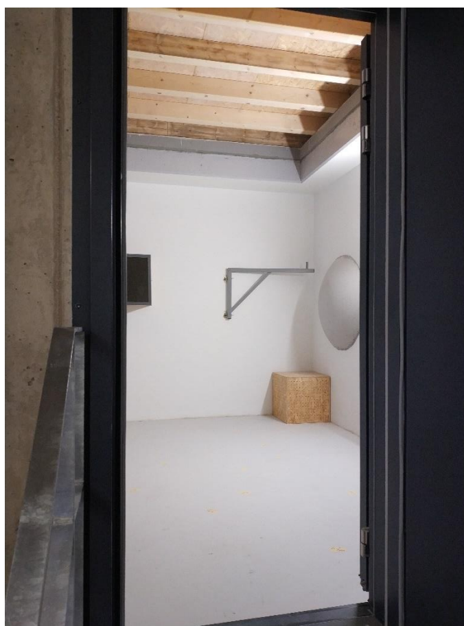
Obrázek 54 - Spodní pohled na „strop 1“
