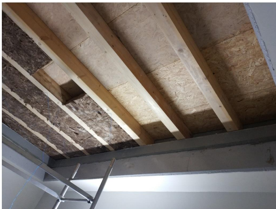
Obrázek 56 - spodní pohled na „strop 2“ - částečně vložena izolace
