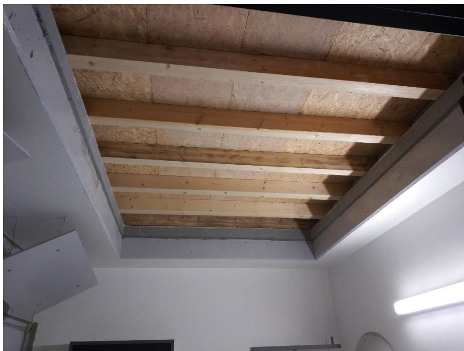
Obrázek 53 - Spodní pohled na „strop 1“ ze dveří akustické komory
