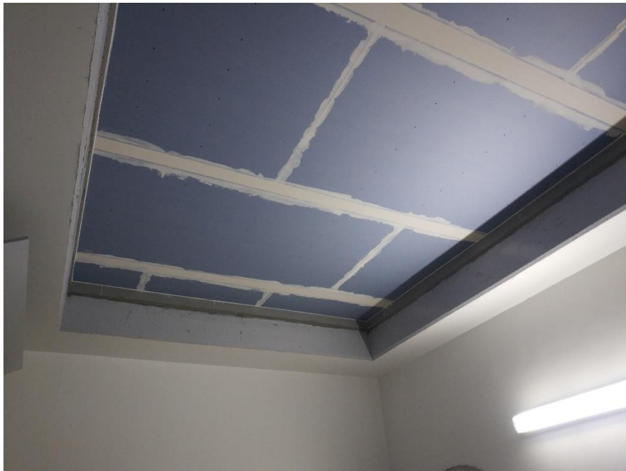
Obrázek 58 - Spodní pohled na „strop 2“
