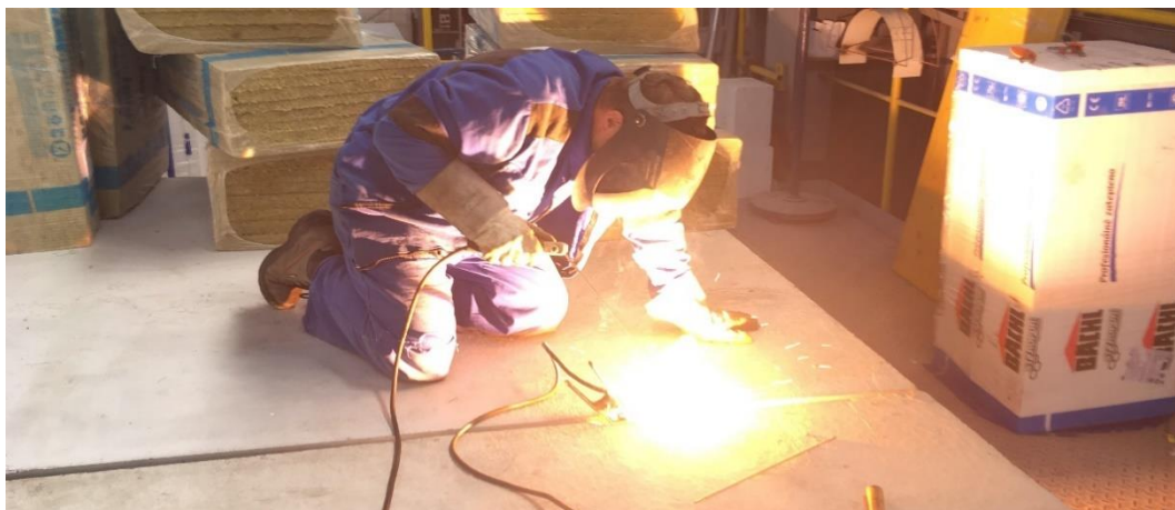
Obrázek 63 – Provádění svaru technikem zkušebny
