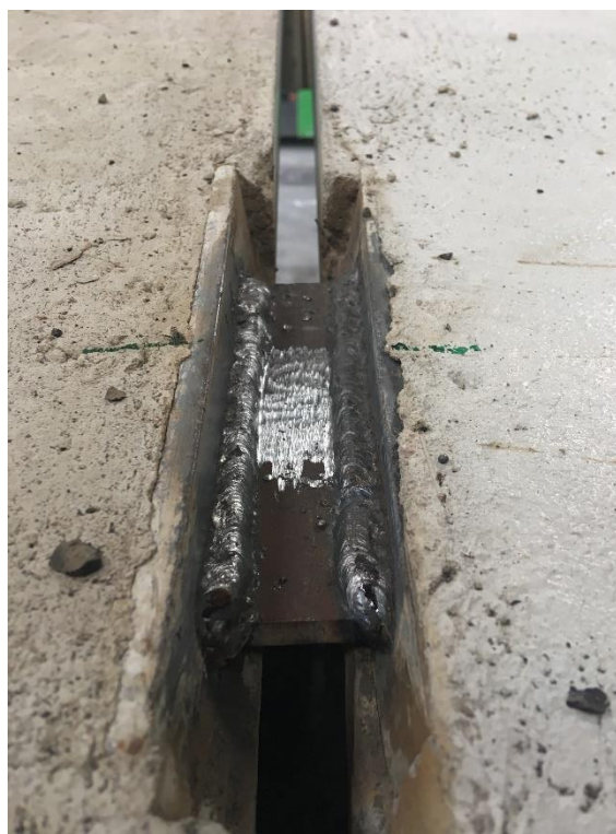
Obrázek 65 – Spoj po provedení svaru
