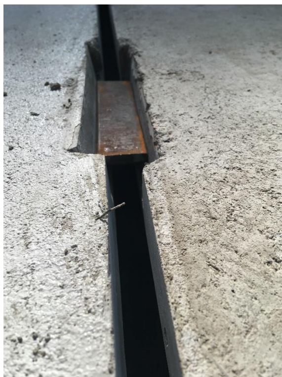
Obrázek 64 – Spoj před provedením svaru
