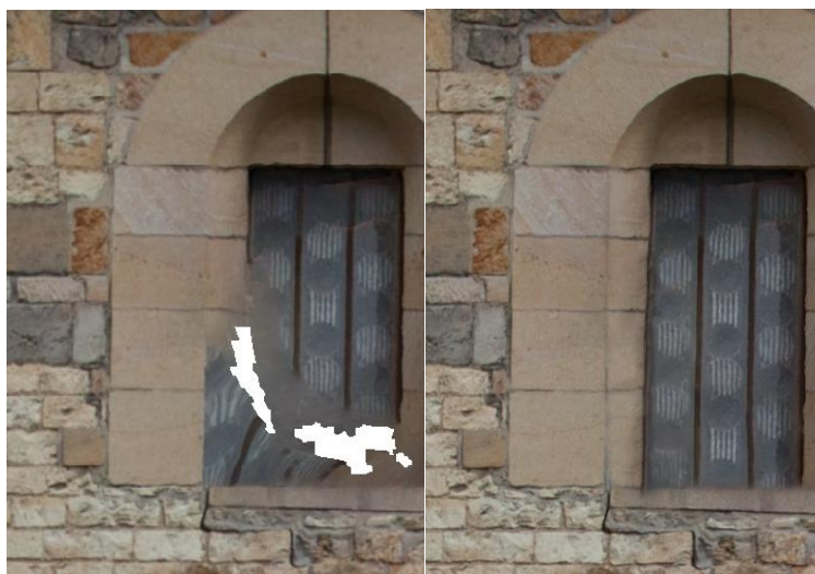
Obr. 25 - Srovnání okna před opravou a po ní
