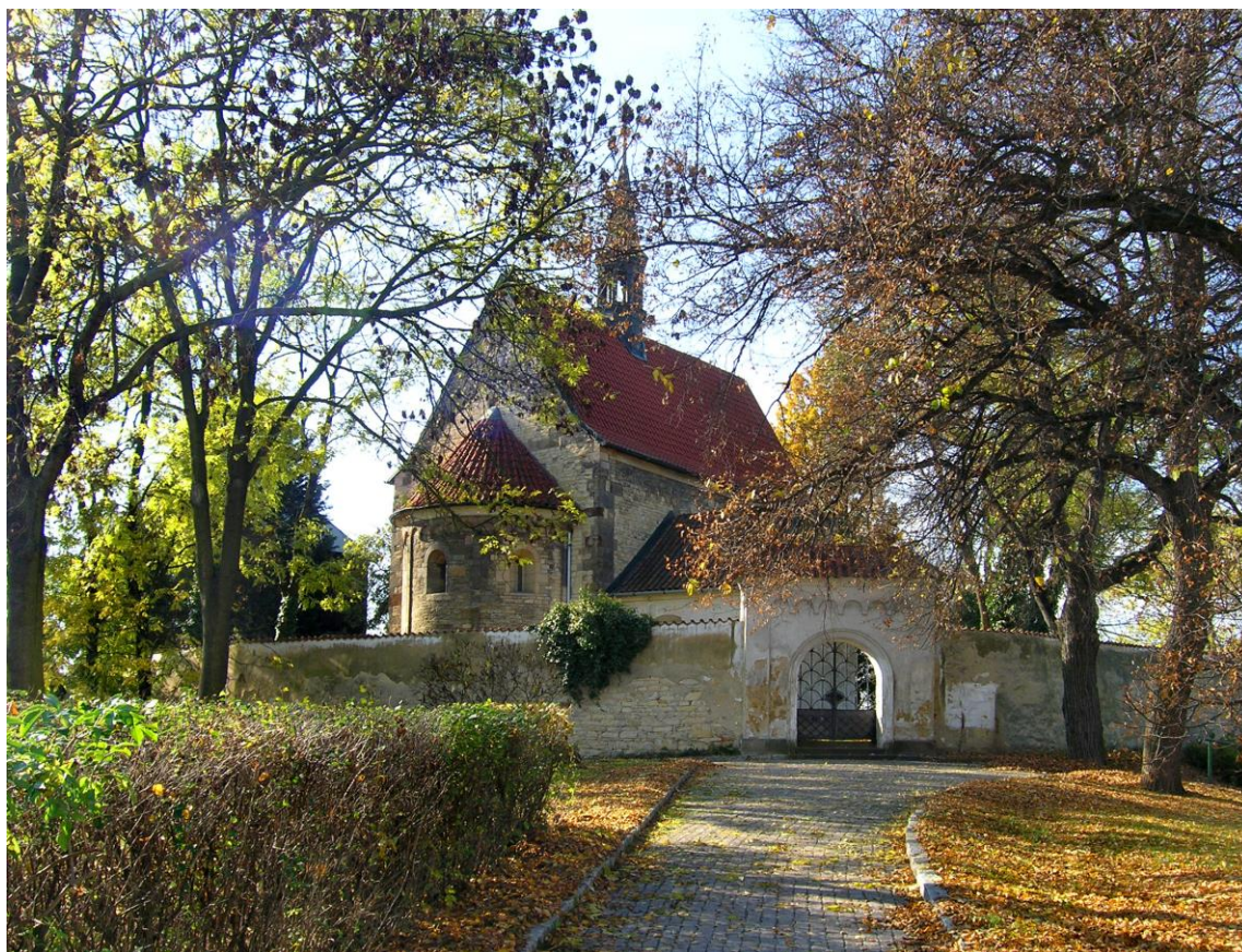
Obr. 1 - Pohled na kostel z Bíleneckého náměstí
