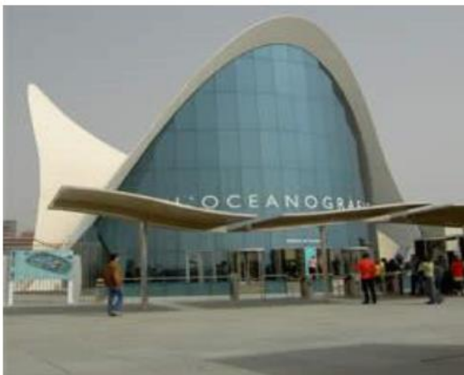
Obr. 8: Drátkobetonová střešní konstrukce Evropského Oceánografického parku ve Valencii [13]
