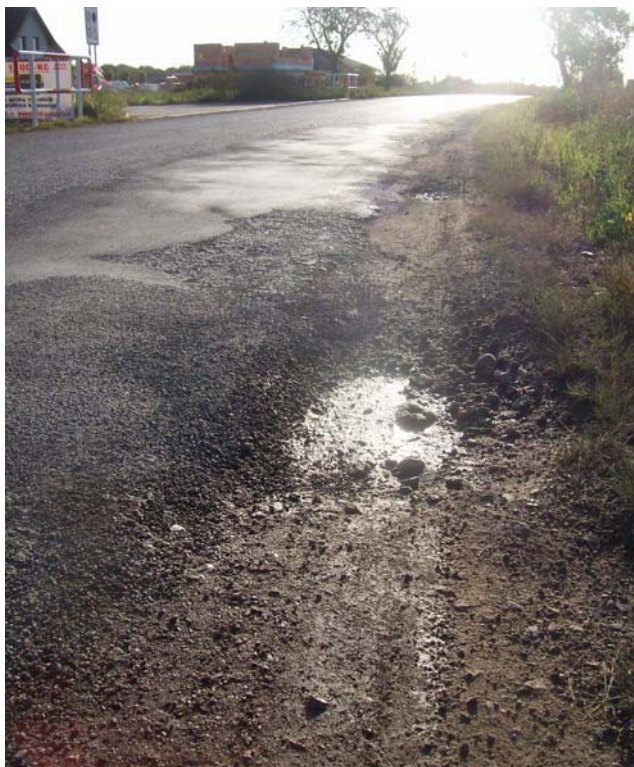
5. Ztráta makrotextury povrchu vozovky
