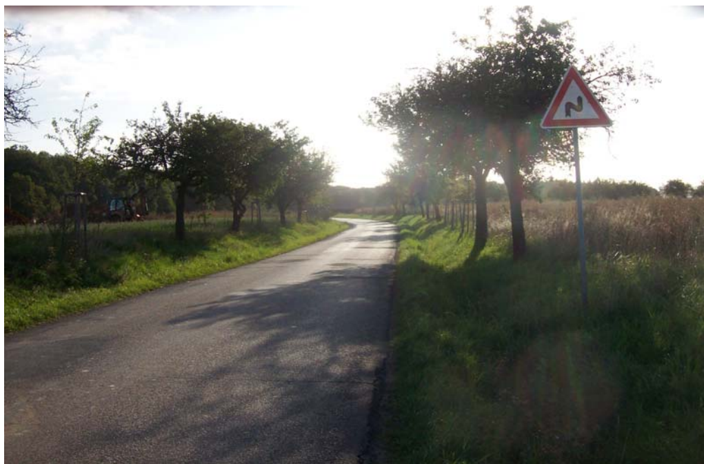
4. Směrový oblouk silnice III. třídy
