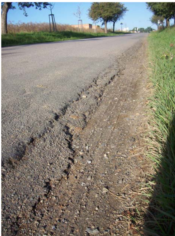
11. Odlamování vrstev vozovky
