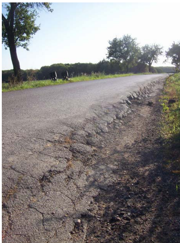
12. Odlamování vrstev vozovky
