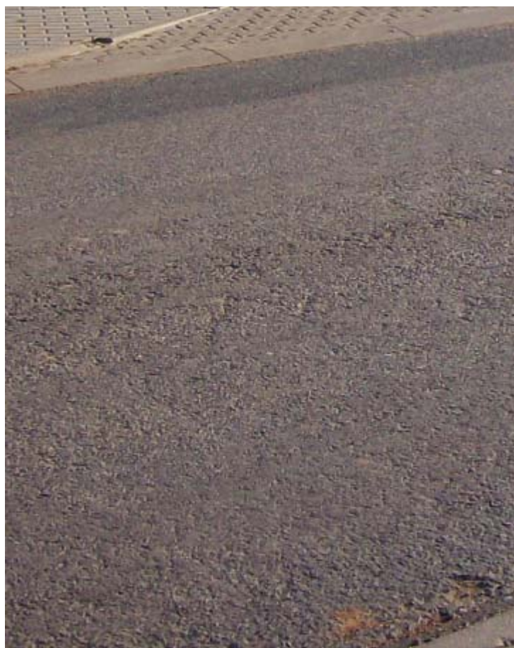
8. Drobné jamky po vylomění větších zrn kameniva
