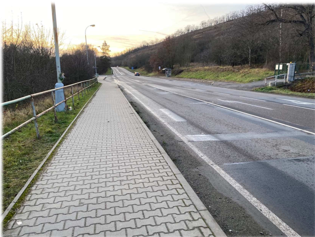
Obrázek 2 – Stávající autobusové zastávky směrem k obci Vráž
