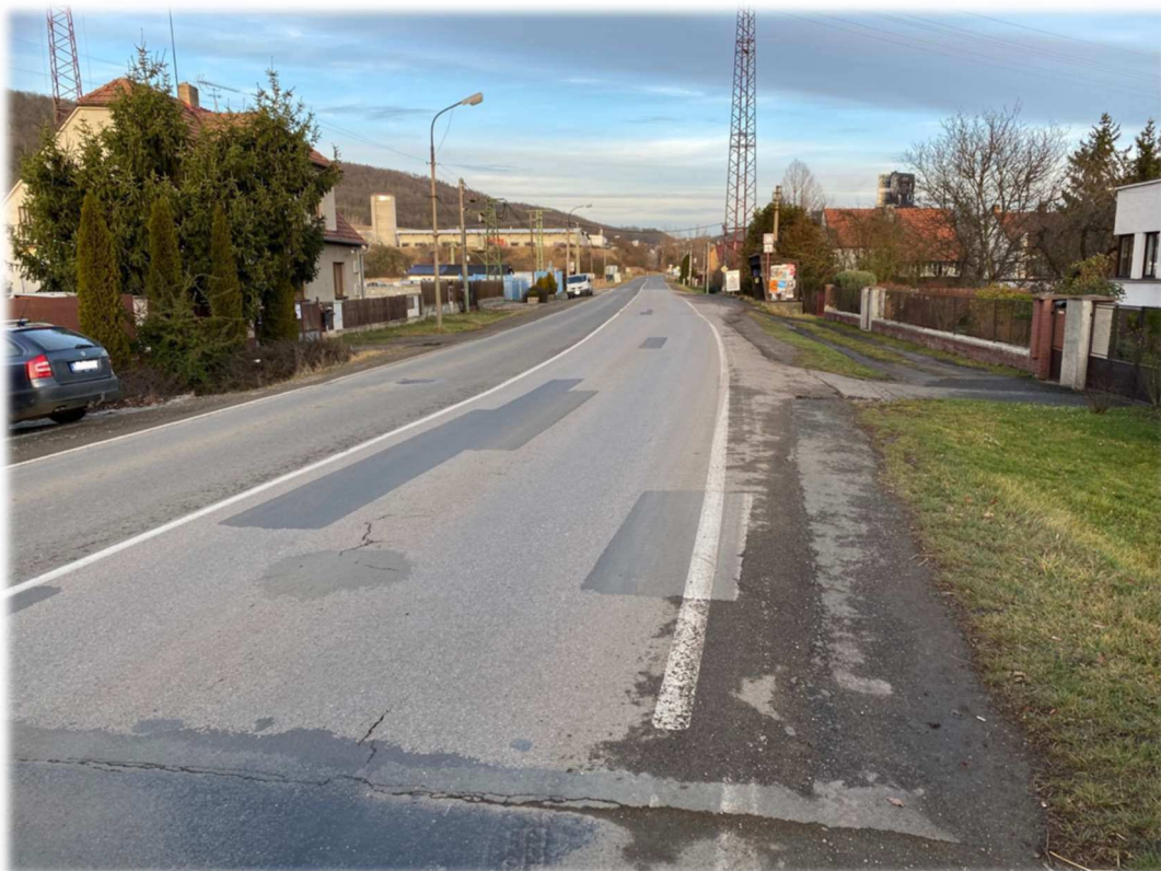
Obrázek 40 – Chybějící pěší infrastruktura
