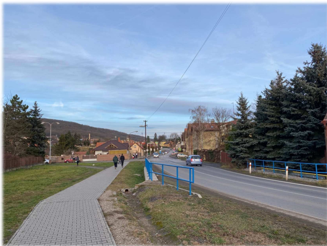
Obrázek 32 – Pohled na ulici od stávajícího mostu (rekonstruovaný v roce 2016)
