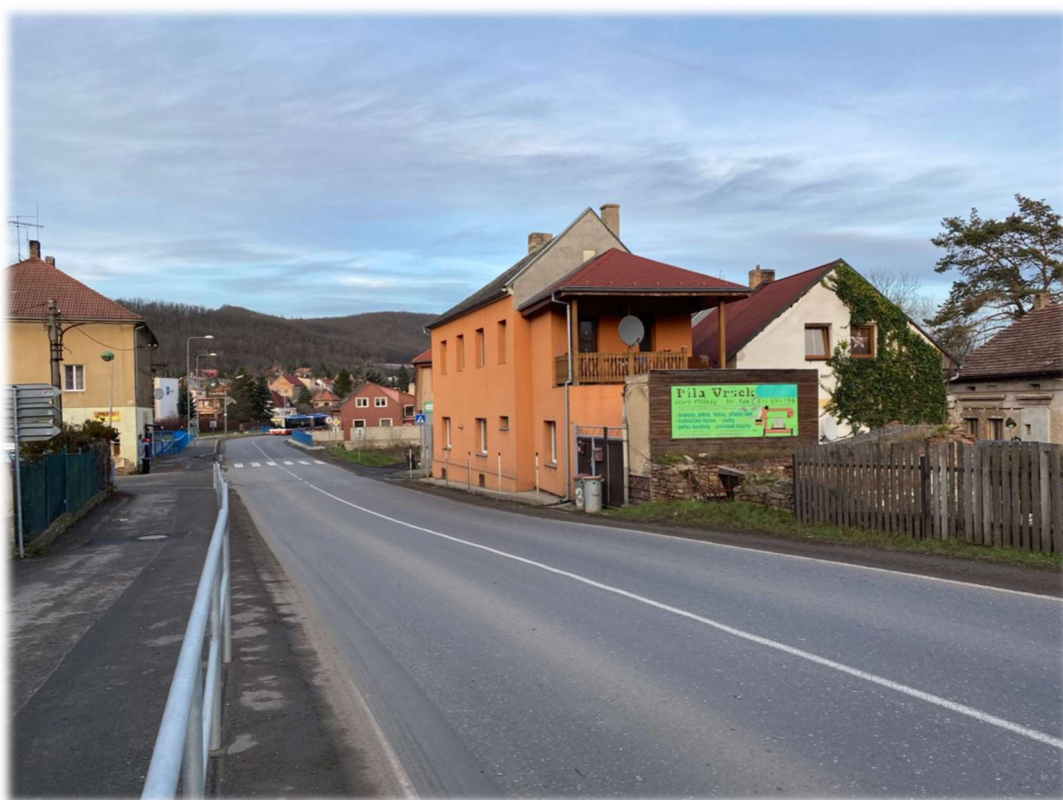
Obrázek 29 – Pohled na stávající most
