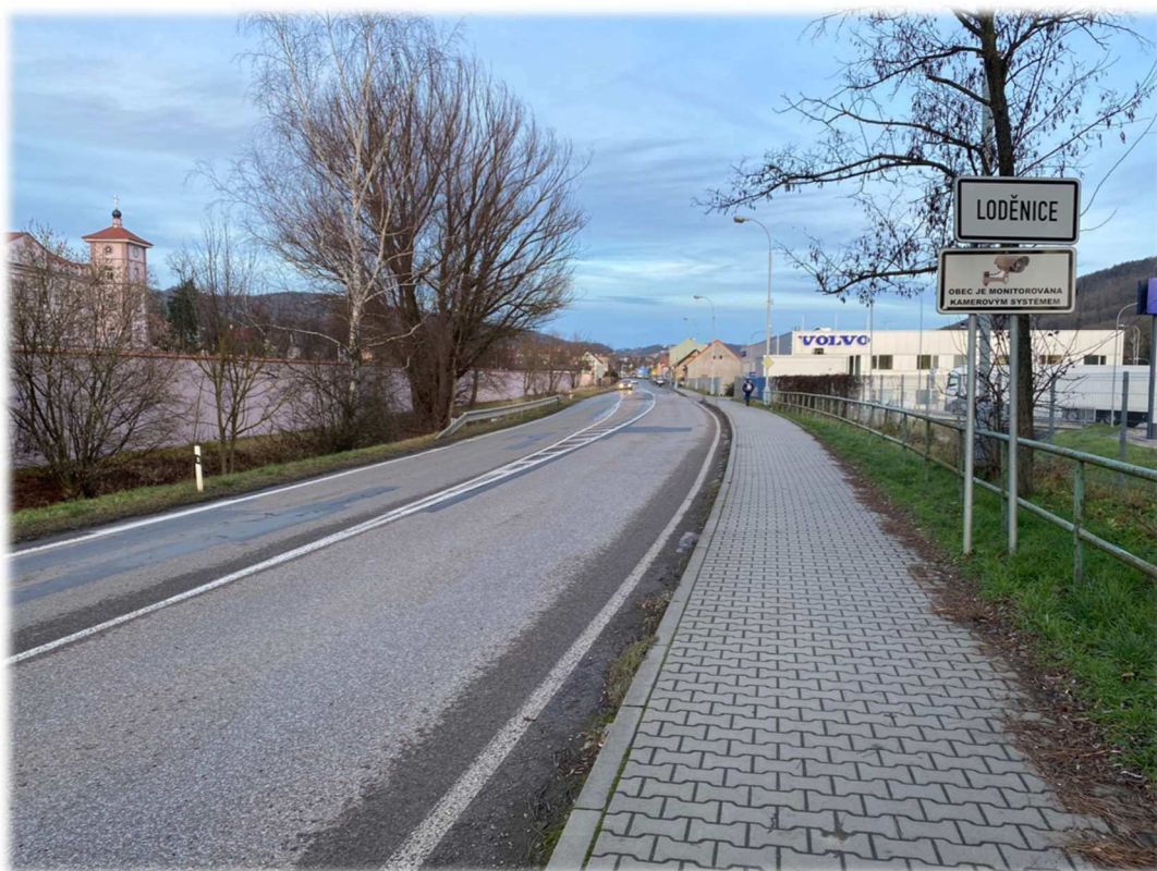
Obrázek 5 – Vjezd do obce Loděnice
