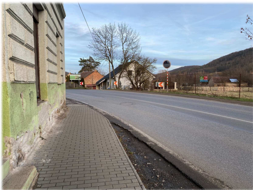
Obrázek 27 – Nebezpečné místo chodníku
