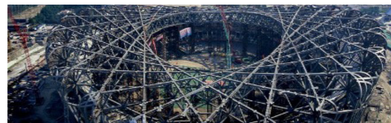
obr. č.26. stadion při výstavbě z roku 2006
