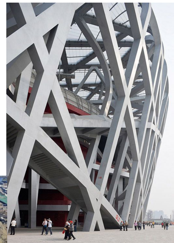
obr. č.27. Detail propletených nosníků, který tvoří obálku stadionu
