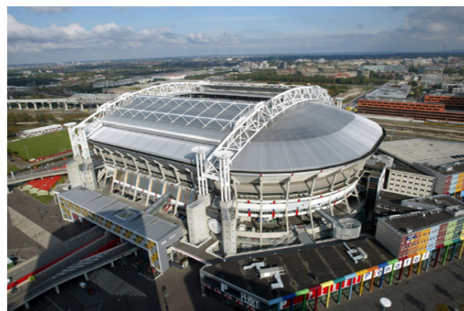
obr. č.16. Stadion pro Ajax Amsterdam s pohyblivou střechou
