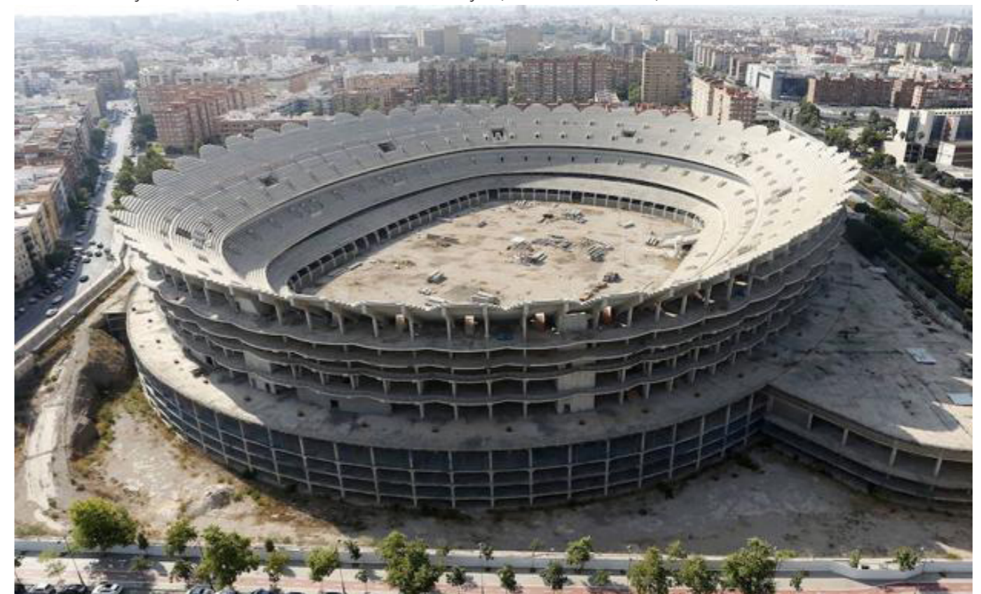
obr. č.22. betonová superstruktura ve výstavbě
