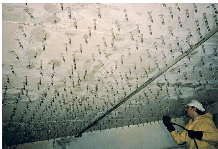
Obr. 32: Sanace plošného průsaku – vrtané pakry [13]
