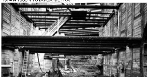
1974 A 1985 VÝSTAVBA METRA
