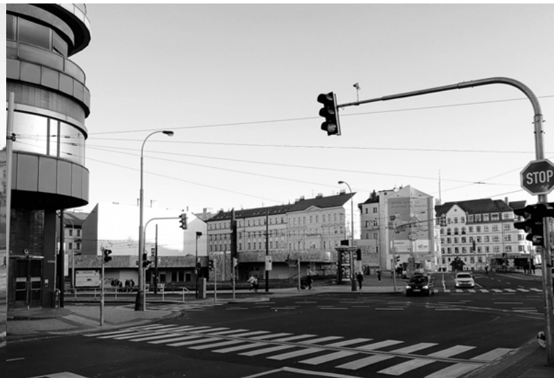
PROVIZORNÍ BUDOVA STANICE METRA
