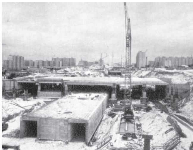
Výstavba stanice metra Opatov a sídliště v pozadí (1980)
