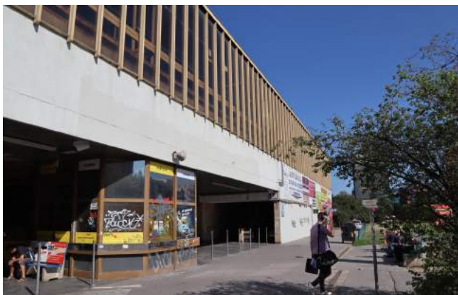
7| Pohled na stanici z prostřední úrovně
