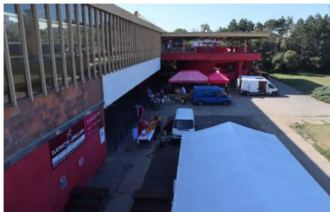
2| Pohled z horní úrovně stanice na „šneka“ a trhy
