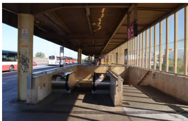
6| Schody spojující horní a prostřední úroveň stanice
