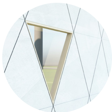
Těžký obvodový plášť - cementovláknité desky
