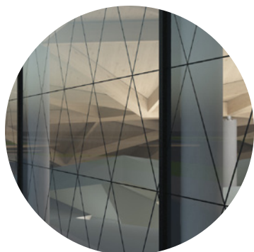
Lehký obvodový plášť - velkoformátové bezpečnostní sklo
