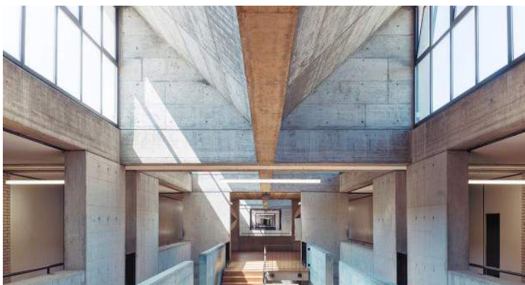
Obr.27 Morbio school - pohľad na stredný trakt
