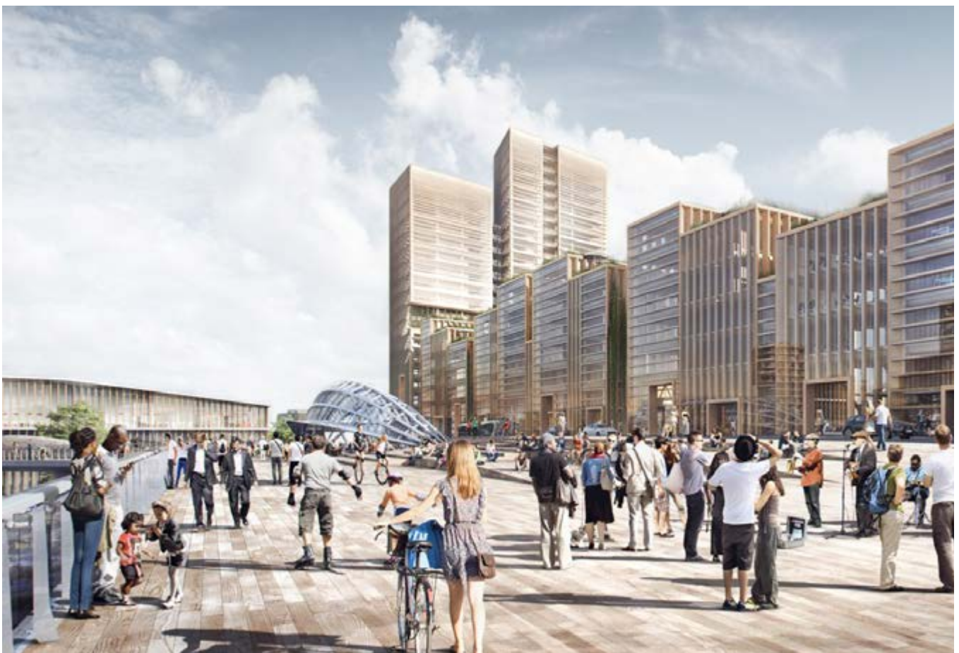
Obr. 31 | Pohled z nově budované ulice - mostu
