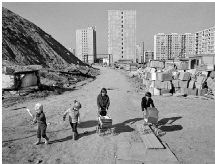
Obr. 8 | Improvizované obývání sídliště
