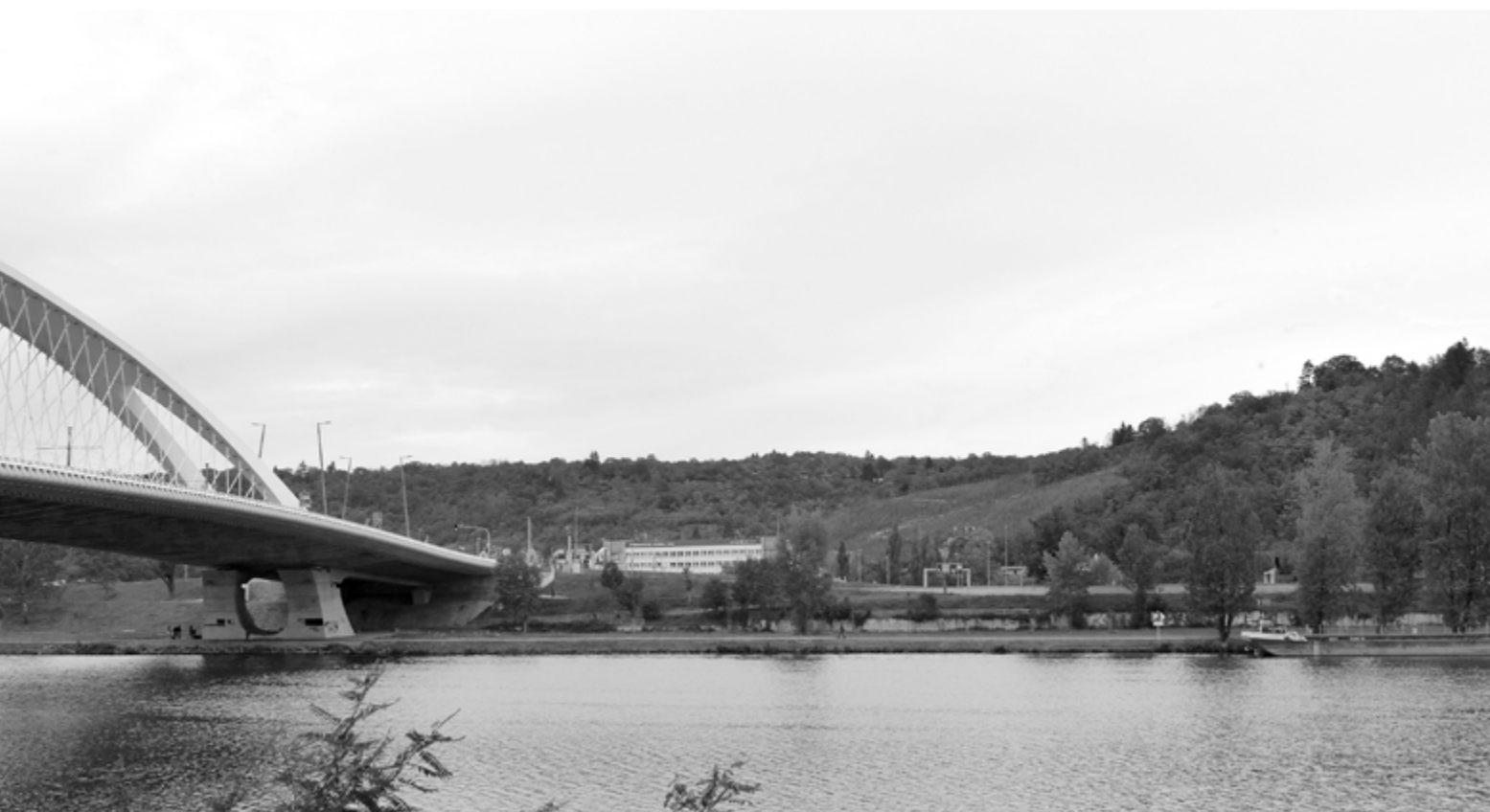
Pohled z holešovického břehu na Trojský most
