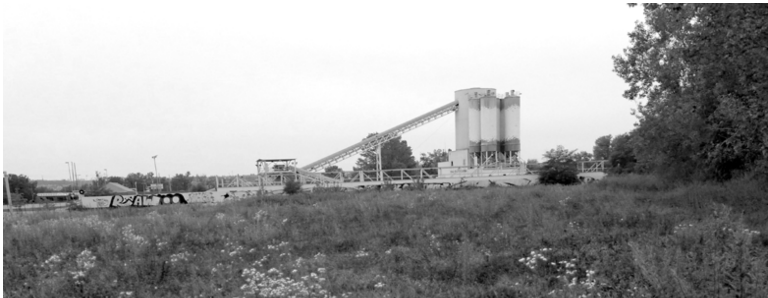
Betonárna s divokou loukou v popředí
