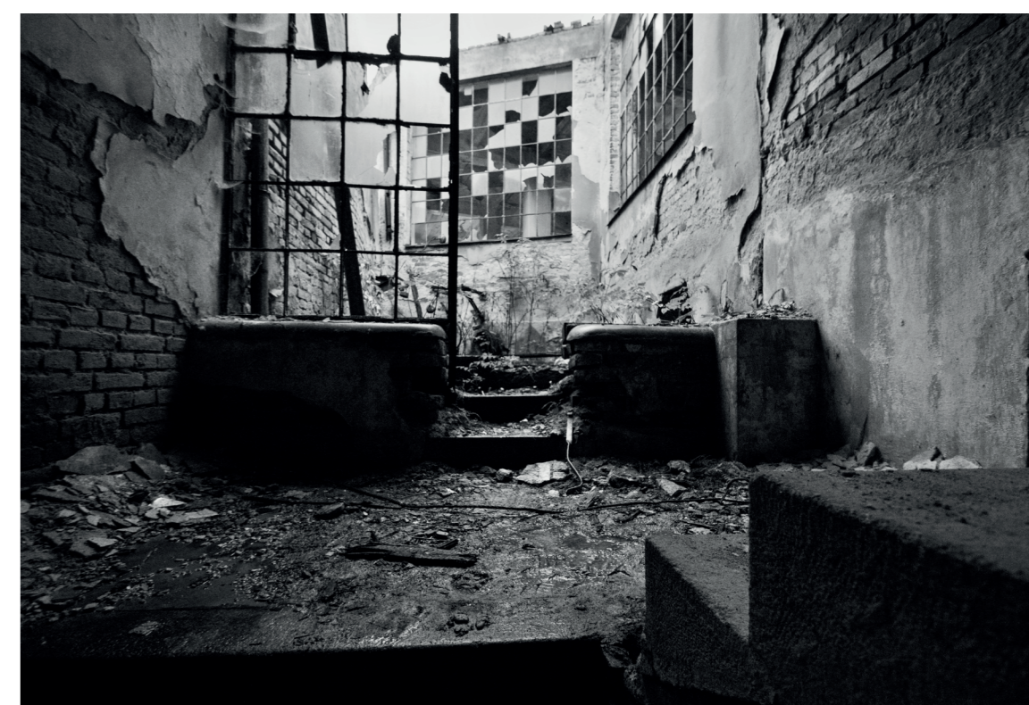
současný stav schodišových prostor
