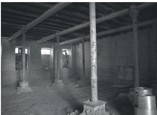
nosná konstrukce v přízemí
