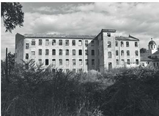
východní pohled z vnitrobloku
