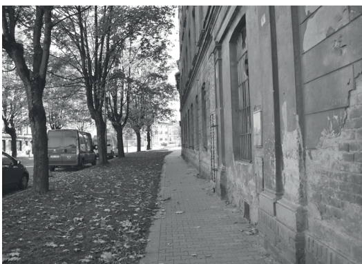
detail uliční fasády
