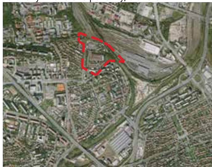
před 2008 - výstavba obytných domů, výstavba na Brumlovce
