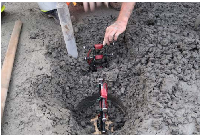
Obr. 3 Svislý řez měřícím bodem (Foto: S. Šulc)
