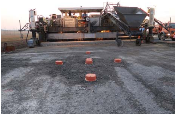
Obr. 1 Rozmístění čidel (Foto: S. Šulc)
