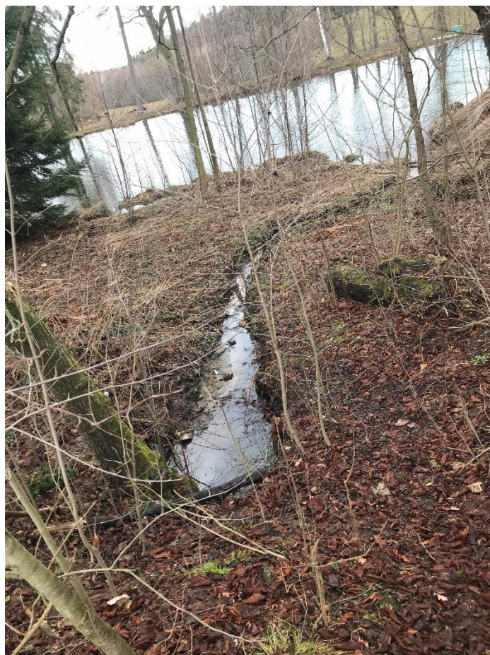
Foto 13 – Odtok spodní výpusti rybníka se pstruhy
