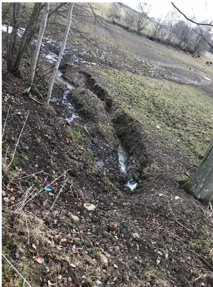
Foto 16 – Nezpevněné koryto spodní výpusti Spodního rybníka
