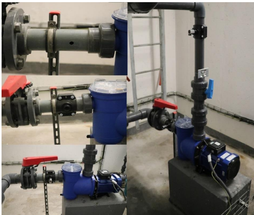
Obr. 54 Provedení navrtávky potrubí a umístění tlakových sond
