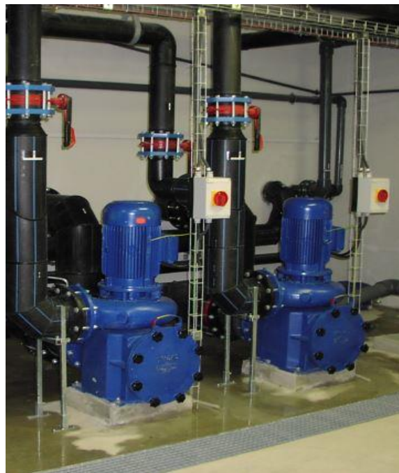
Obr. 14 Zapojení a umístění bazénových čerpadel [4]
