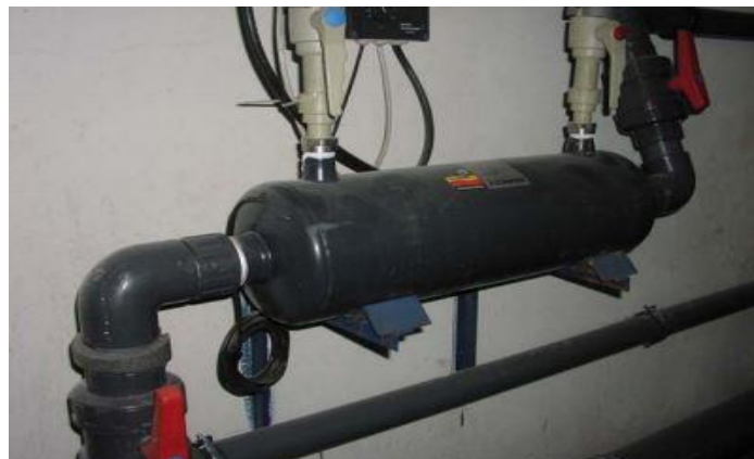
Obr. 17 Tepelný trubkový výměník [4]
