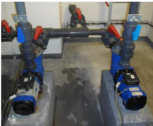
Obr. 44 Umístění a zapojení stávajících čerpadel
