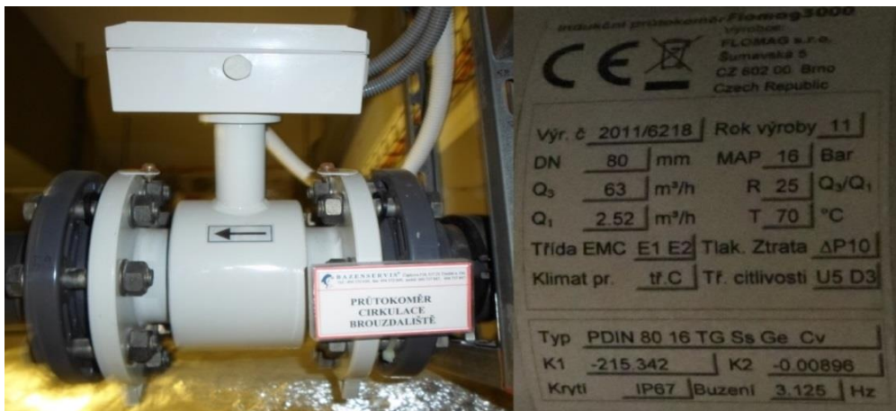
Obr. 58 Napevno instalovaný indukční průtokoměr a štítek daný výrobcem
