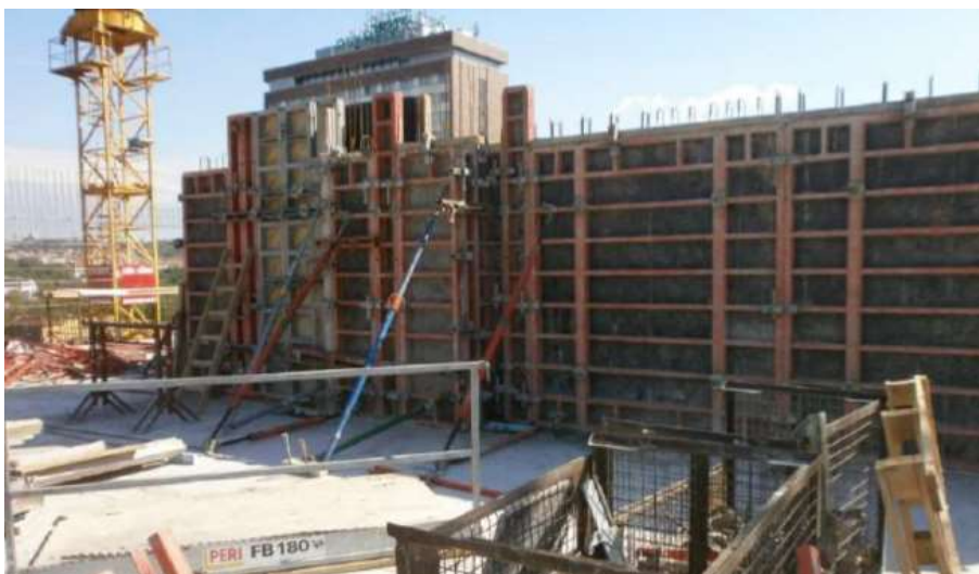
Obr. 28 - Bednění svislých konstrukcí Zdroj: [14]
