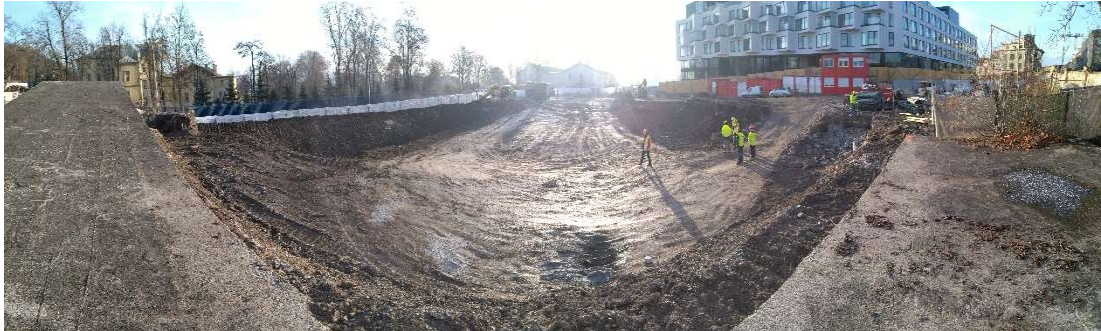
Obr. 20 - Panorama zajištění stavební jámy Rezidence Vitality Zdroj: vlastní
