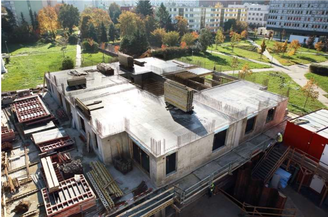
Obr. 33 - 2.NP objektu "C" při bednění stropu Zdroj: [14]
