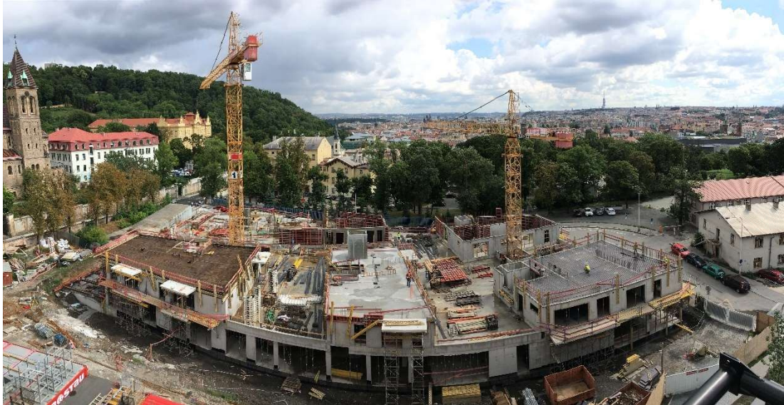
Obr. 35 - Pohled na realizaci monolitické konstrukce 2.NP projektu Vitality Zdroj: vlastní
