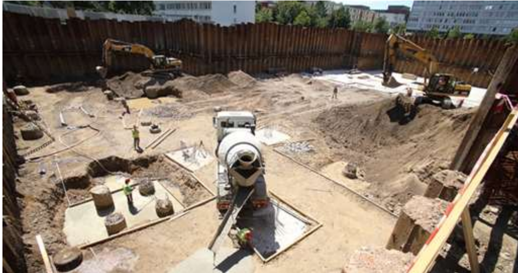
Obr. 16 - Stavební jáma Kindergarten při zakládání Zdroj: vlastní
