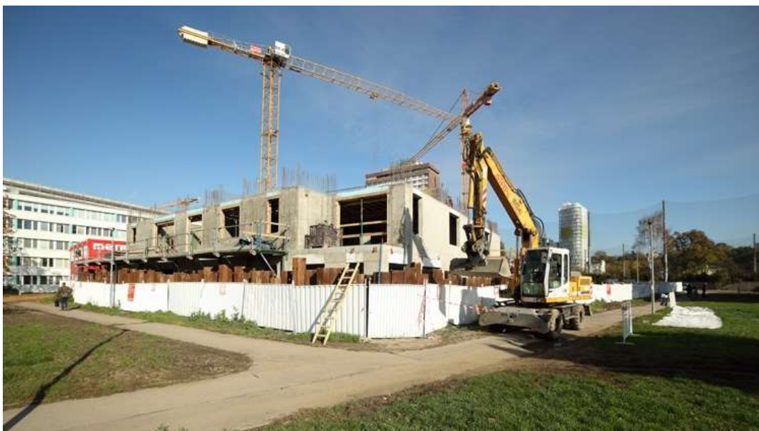
Obr. 32 - Realizace monolitické konstrukce 2.NP projektu Kindergarten Zdroj: [14]
