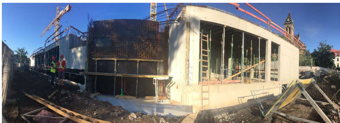
Obr. 30 - Podpěrná konstrukce stropu 1.NP Zdroj: vlastní
