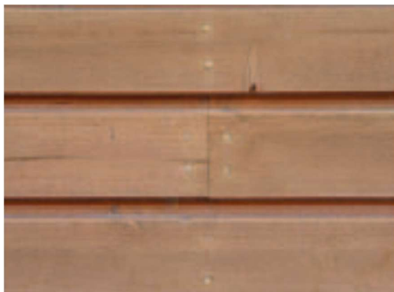
Obrázek 16 - Viditelné upevnění vodorovné
