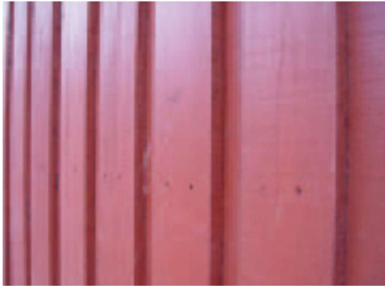
Obrázek 17 - Viditelné upevnění svislé
