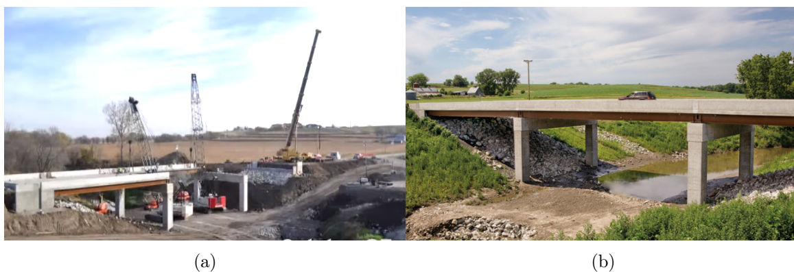
Obrázek 2.8: Výměna mostu Iowa U.S. 6 přes koryto řeky Keg. (a) a nově zhotovená mostní konstrukce (b) pomocí metody ABC a implementace postupu podle ABC Toolkit .
