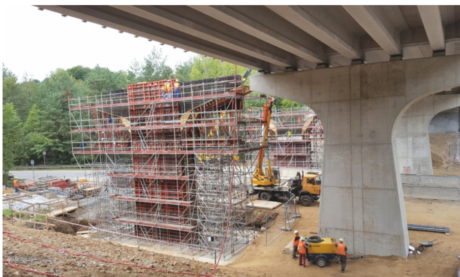
Obrázek 3.3: Montáž bednění pilíře pravého mostu (vlevo) a dokončený pilíř levého mostu (vpravo). Komentář i obrázek převzaty z [10].
