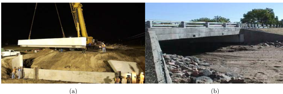
Obrázek 2.9: Výměna mostu 86 přes Mitchel Gulch probíhající v noci pomocí jeřábu (a) a již kompletně zhotovený nový most 86 z prefabrikovaných dílů (b). Zdroj:
