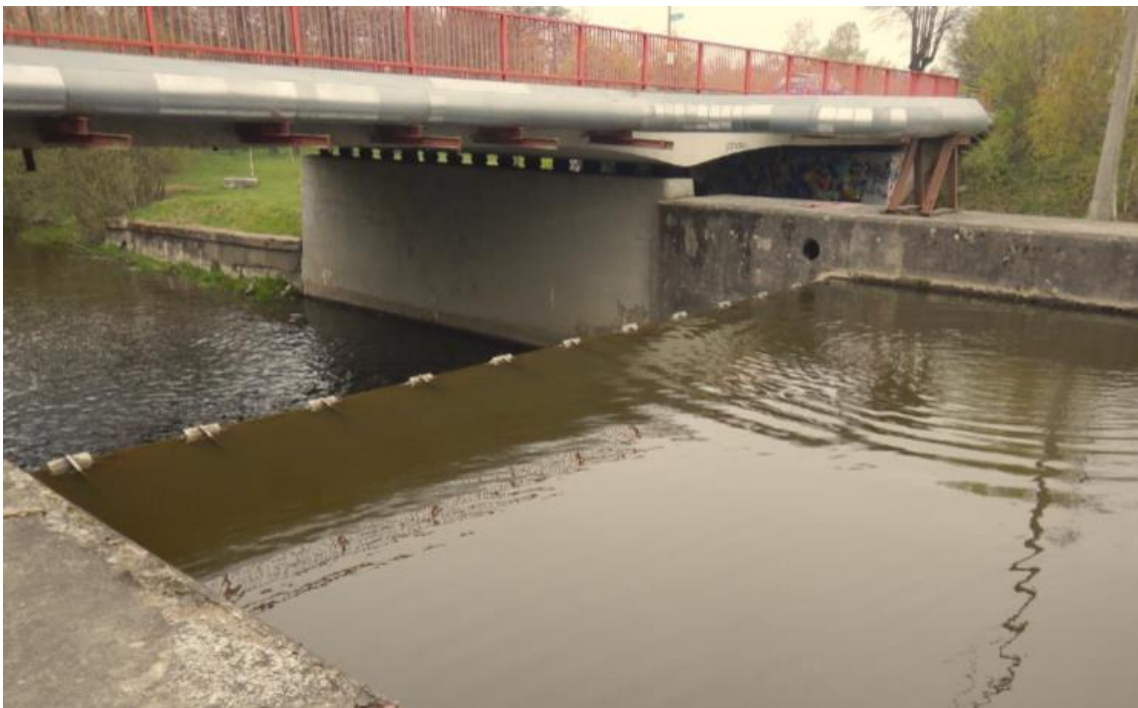
Obrázek 2.2 Fotka Jermářova jezu a mostu s teplovodem [8]
