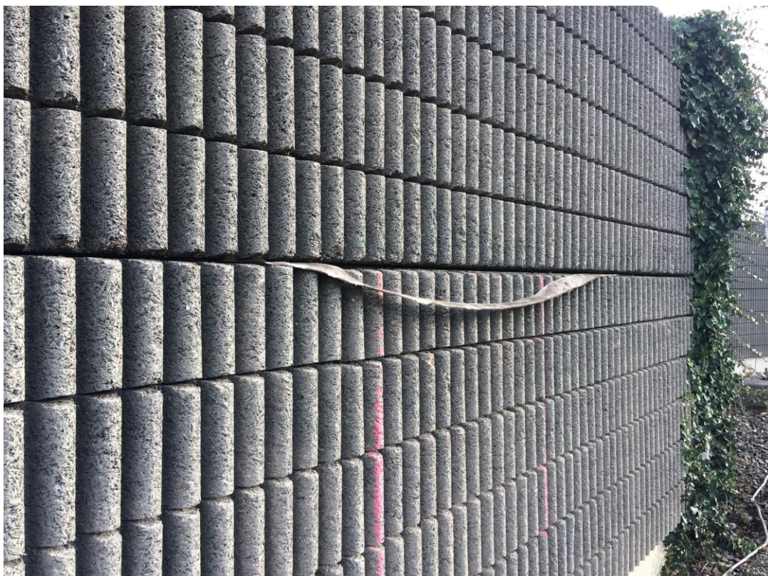
Obr. 22: Stanoviště I – tkanina ve spáře mezi dvěma panely PHS
