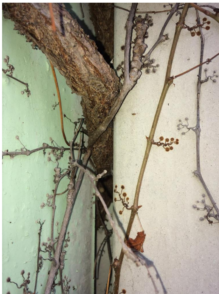
Obr. 27: Detail prorůstání PHS dřevinami
