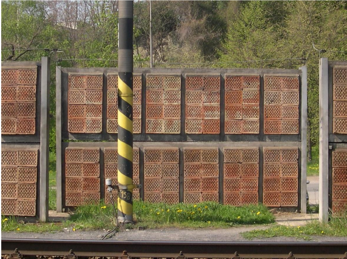
Obr. 7: Děrované cihly v betonovém rámu [9]
