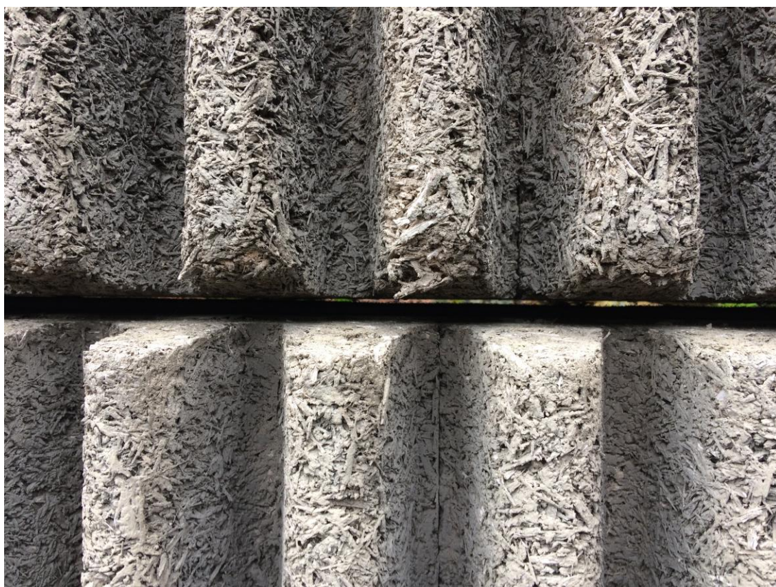
Obr. 6: Dřevocementové pohltivé panely (Strančice 2019/10)
