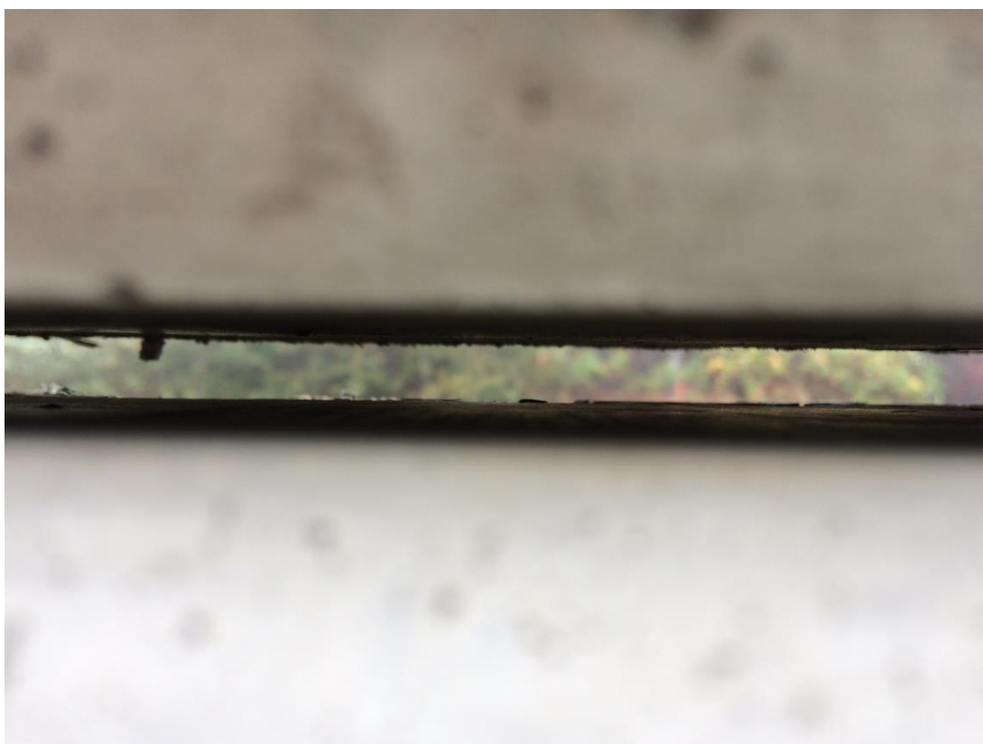
Obr. 23: Stanoviště I – mezera spáry mezi dvěma panely PHS
