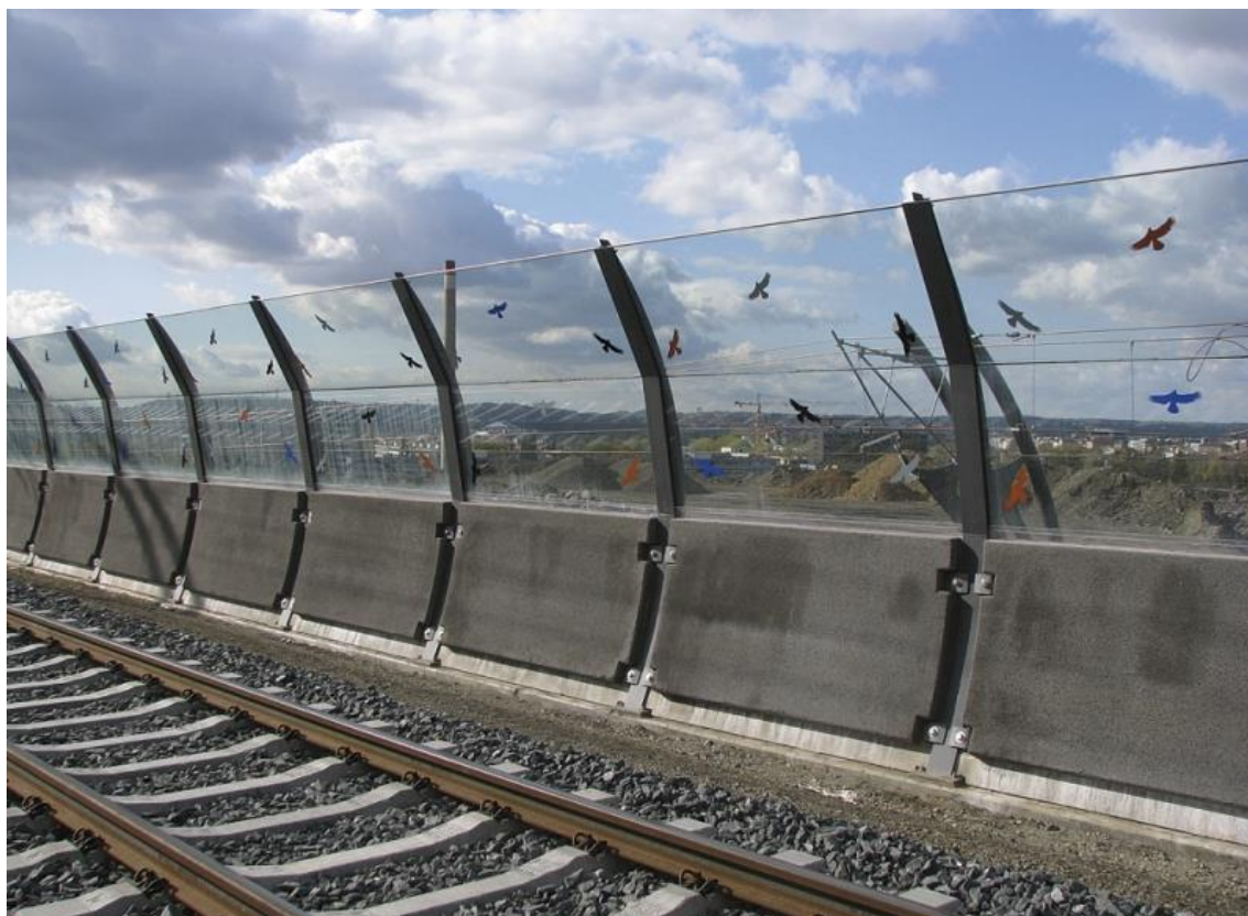
Obr. 10: Transparentní PHS v kombinaci s porézním betonem [9]
