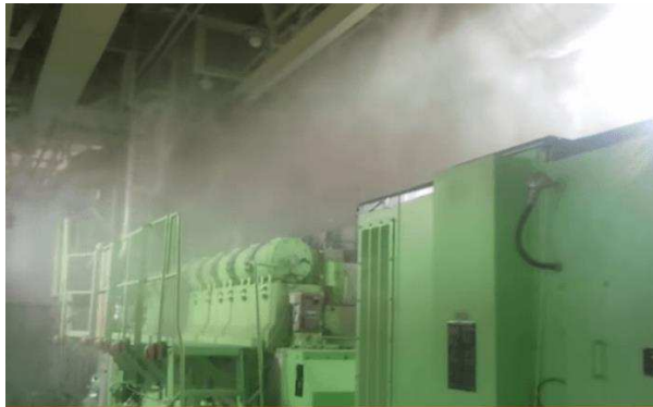
Obr. 20 – Ochrana elektrického zařízení pod napětím vodní mlhou [19]
