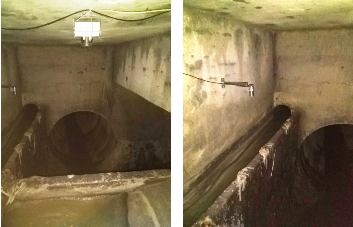
Obrázek 32: Hladinové sondy pro měření hladin v OK u náměstí [fotografie autorky]
