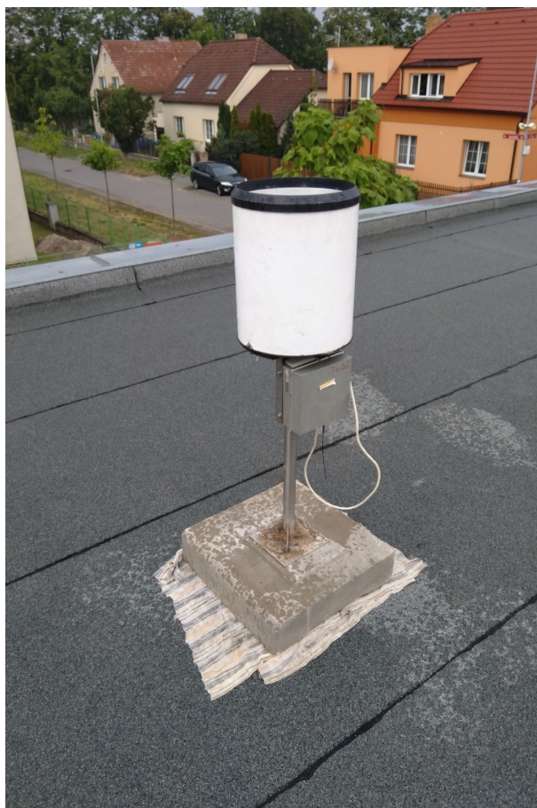
Obrázek 59: Osazený srážkoměr na střeše garáže [fotografie autorky]
