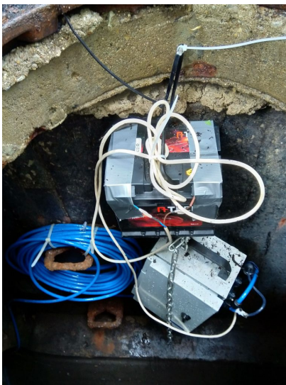
Obrázek 29: Fiedler Q2 pro měření průtoku 2 šachty před OK u ČOV [fotografie autorky]
