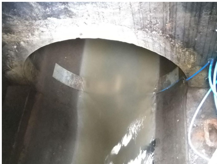
Obrázek 29: Fiedler Q2 pro měření průtoku 2 šachty před OK u ČOV [fotografie autorky]
